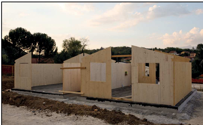
Fig.73 - Avanzamento lavori M.A.P. di Villa Sant'Angelo -
