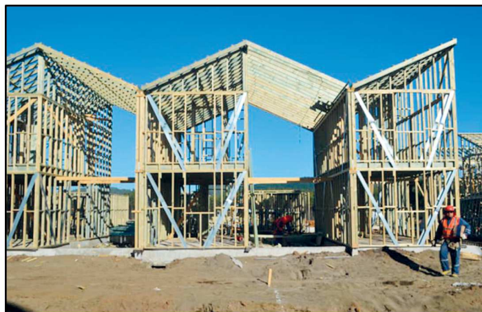
Fig.35 - Avanzamento lavori e fasi di cantiere -
