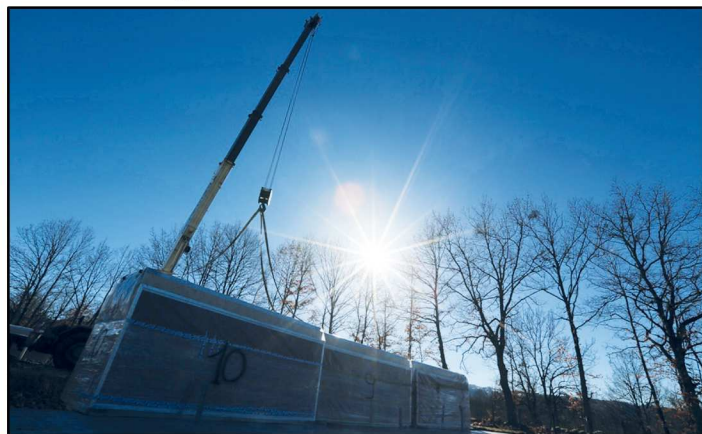
Fig.110 - S.A.E. realizzate ad Amatrice (Campo0)-
