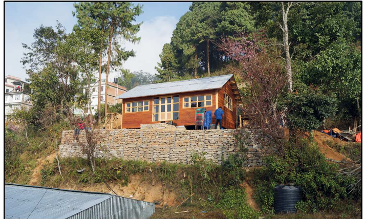
Fig.173 - Avanzamento lavori e fasi di cantiere del progetto Charikot Veneer House, Dolakha (Nepal) 2015 -
