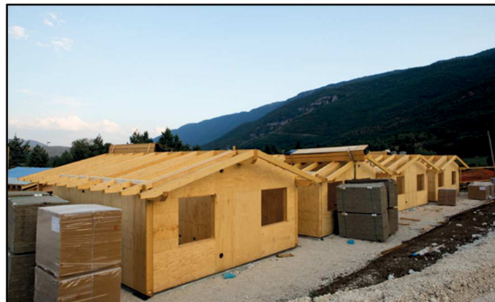
Fig.74 - Avanzamento lavori M.A.P. di Villa Sant'Angelo -
