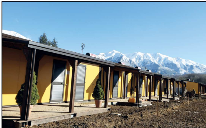
Fig.113 - S.A.E. realizzate ad Amatrice (Campo0) -
