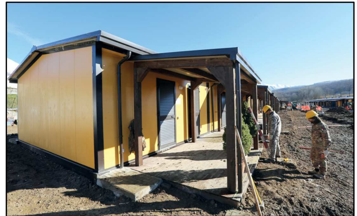
Fig.114 - S.A.E. realizzate ad Amatrice (Campo0) -
