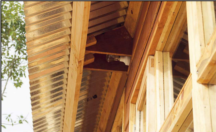
Fig.172 - Avanzamento lavori e fasi di cantiere del progetto Charikot Veneer House, Dolakha (Nepal) 2015 -
