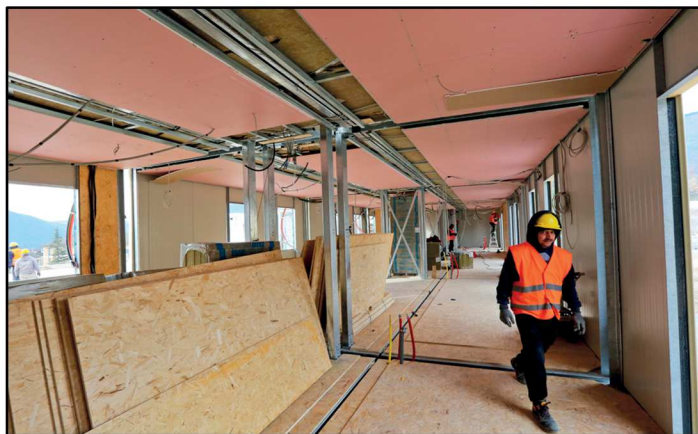
Fig.98 - Avanzamento lavori delle S.A.E. di Norcia -
