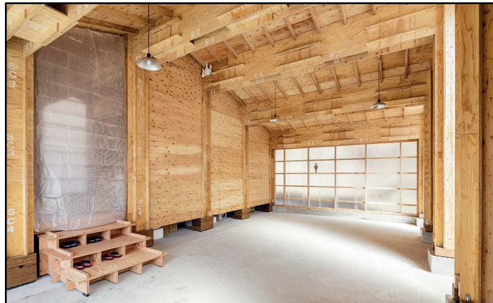
Fig.161 - Avanzamento lavori e fasi di cantiere del progetto Veneer House di Maeamihama, Miyagi (Giappone) 2013 -
