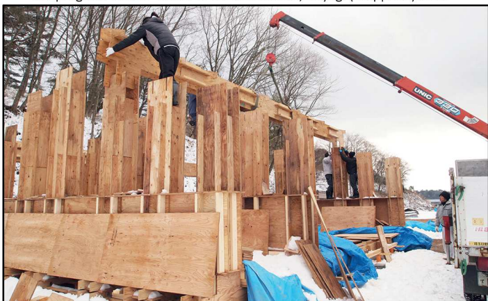
Fig.143 - Avanzamento lavori e fasi di cantiere del progetto Veneer House di Minamisanriku, Miyagi (Giappone) 2012 -
