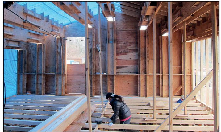
Fig.146 - Avanzamento lavori e fasi di cantiere del progetto Veneer House di Minamisanriku, Miyagi (Giappone) 2012 -
