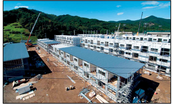
Fig.57 - Fasi di cantiere, Onagawa Container Temporary Housing -
