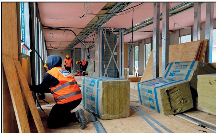
Fig.99 - Avanzamento lavori delle S.A.E. di Norcia -
