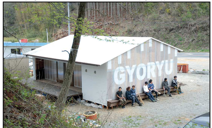
Fig.150 - Avanzamento lavori e fasi di cantiere del progetto Veneer House di Minamisanriku, Miyagi (Giappone) 2012 -
