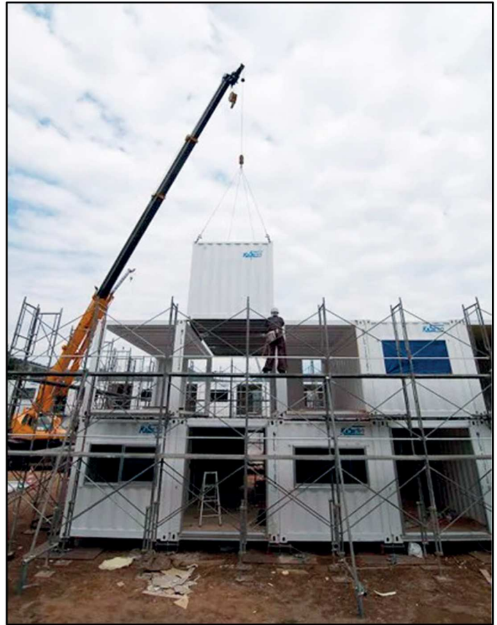
Fig.55 - Fasi di cantiere, Onagawa Container Temporary Housing -
