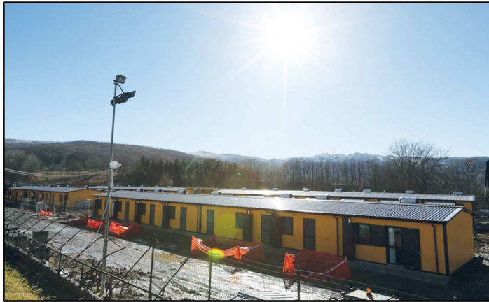
Fig.111 - S.A.E. realizzate ad Amatrice (Campo0) -
