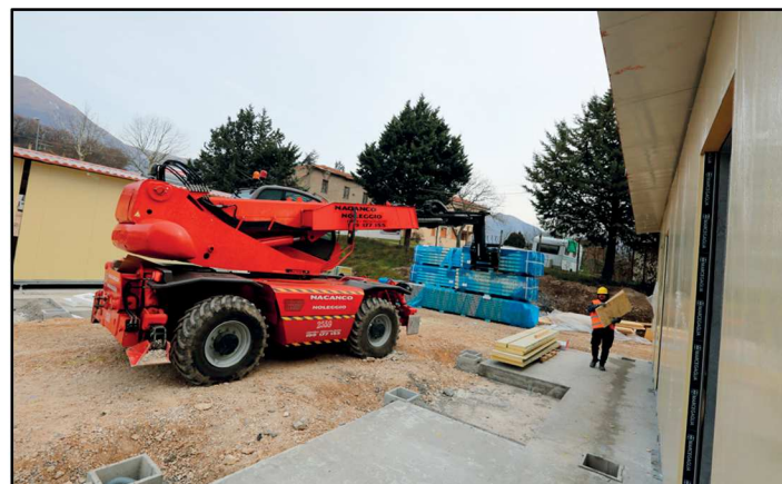
Fig.102 - Avanzamento lavori delle S.A.E. di Norcia -
