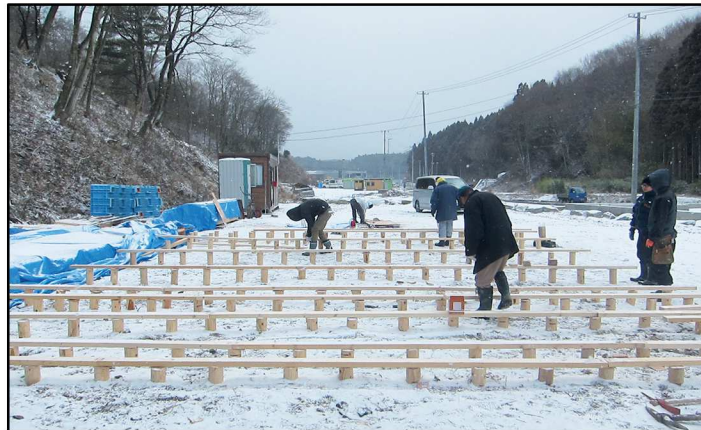
Fig.140 - Avanzamento lavori e fasi di cantiere del progetto Veneer House di Minamisanriku, Miyagi (Giappone) 2012 -
