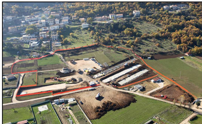
Fig.72 - Area destinata all'installazione dei M.A.P. a Pianola -
