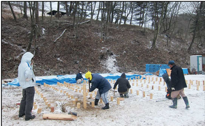
Fig.139 - Avanzamento lavori e fasi di cantiere del progetto Veneer House di Minamisanriku, Miyagi (Giappone) 2012 -
