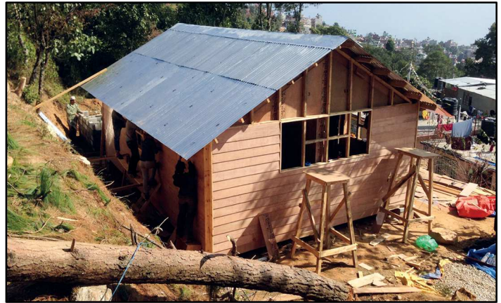
Fig.171 - Avanzamento lavori e fasi di cantiere del progetto Charikot Veneer House, Dolakha (Nepal) 2015 -
