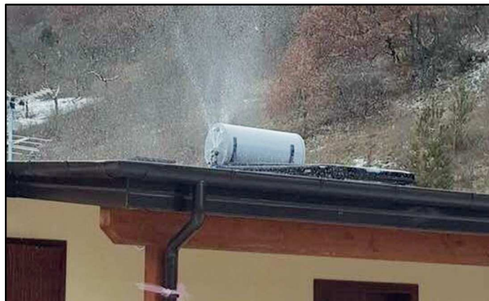
Fig.132 - Un boiler che scoppia a causa delle basse temperature -
