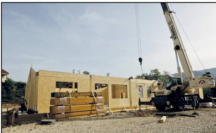
Fig.124 - Il modulo scolastico provvisorio di Acquasanta in costruzione -
