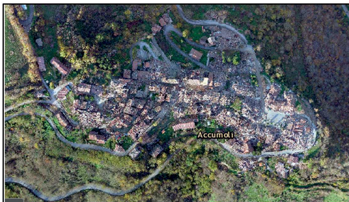
Fig.94 - Accumoli dopo il terremoto -
