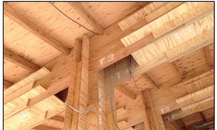
Fig.159 - Avanzamento lavori e fasi di cantiere del progetto Veneer House di Maeamihama, Miyagi (Giappone) 2013 -
