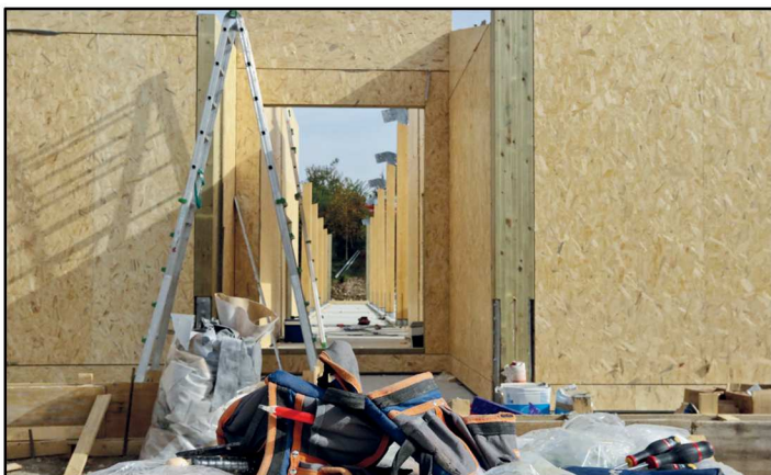
Fig.125 - Il modulo scolastico provvisorio di Acquasanta in costruzione -
