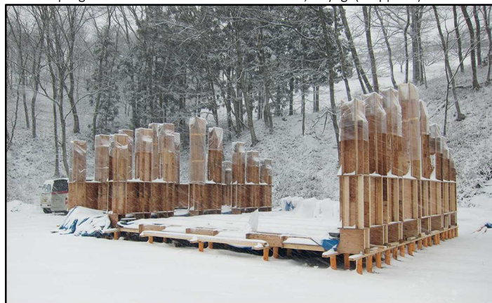
Fig.142 - Avanzamento lavori e fasi di cantiere del progetto Veneer House di Minamisanriku, Miyagi (Giappone) 2012 -
