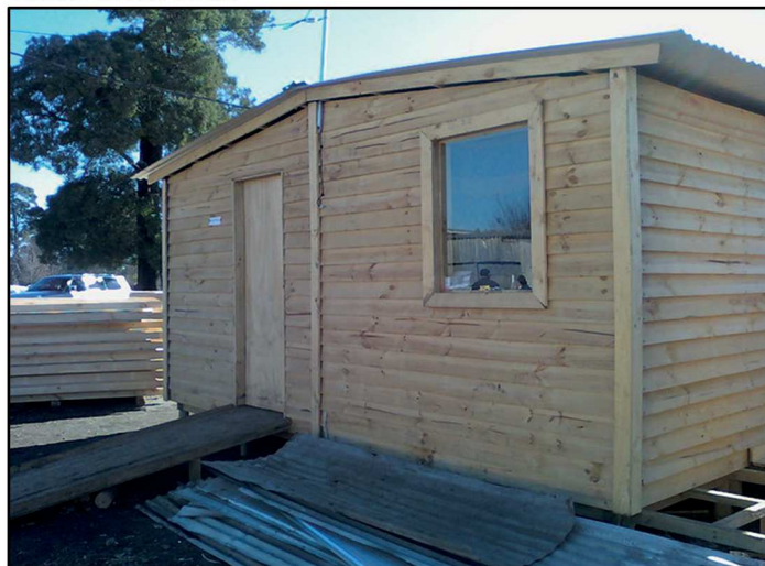
Fig.13 - Mediagua realizzata per i senzatetto in seguito al sisma del 27 Febbraio 2010 -
