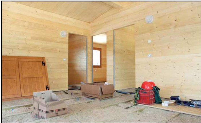
Fig.79 - Avanzamento lavori M.A.P. di Coppito -
