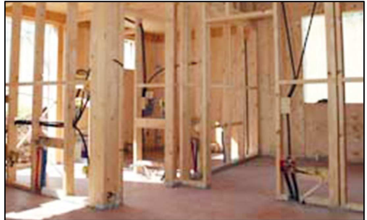
Fig.80 - Avanzamento lavori M.A.P. di Coppito -
