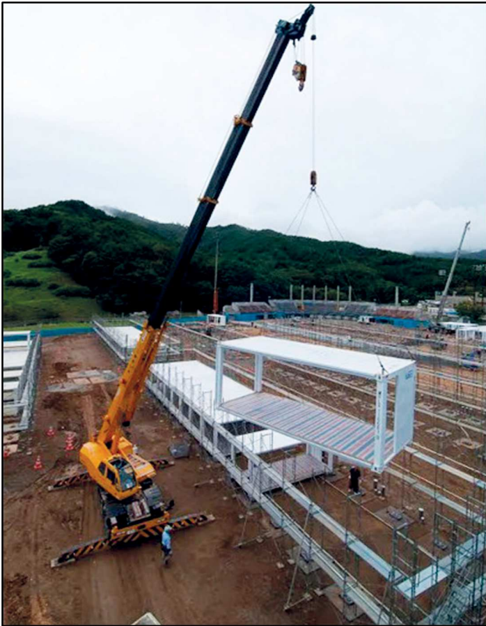
Fig.54 - Fasi di cantiere, Onagawa Container Temporary Housing -
