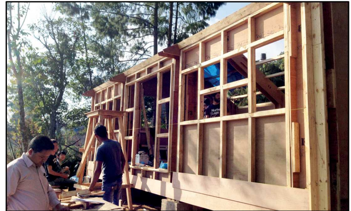
Fig.167 - Avanzamento lavori e fasi di cantiere del progetto Charikot Veneer House, Dolakha (Nepal) 2015 -
