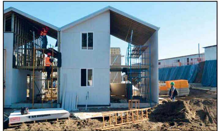
Fig.37 - Avanzamento lavori e fasi di cantiere -
