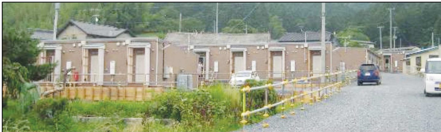
Fig.44 - Esempio di un piccolo rifugio transitorio composto da case temporanee-
