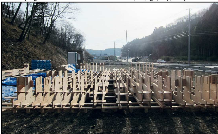
Fig.141 - Avanzamento lavori e fasi di cantiere del progetto Veneer House di Minamisanriku, Miyagi (Giappone) 2012 -
