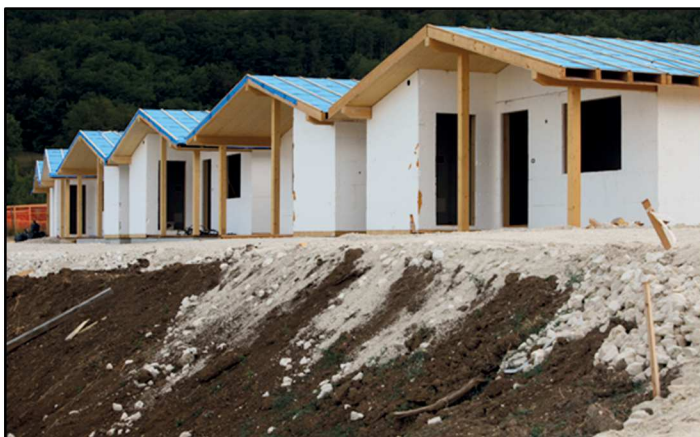
Fig.75 - Avanzamento lavori M.A.P. di Villa Sant'Angelo -
