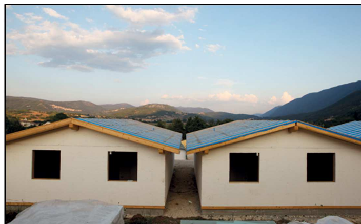
Fig.76 - Avanzamento lavori M.A.P. di Villa Sant'Angelo -
