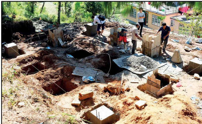
Fig.166 - Avanzamento lavori e fasi di cantiere del progetto Charikot Veneer House, Dolakha (Nepal) 2015 -
