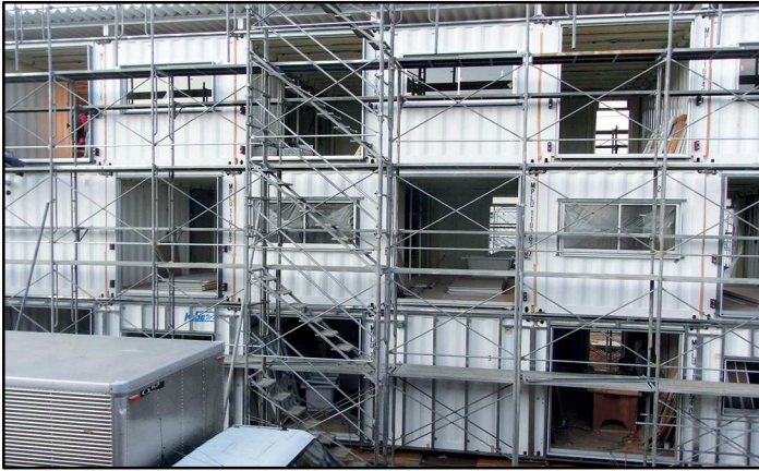
Fig.56 - Fasi di cantiere, Onagawa Container Temporary Housing -
