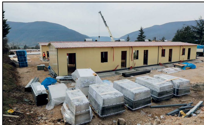
Fig.100 - Avanzamento lavori delle S.A.E. di Norcia -
