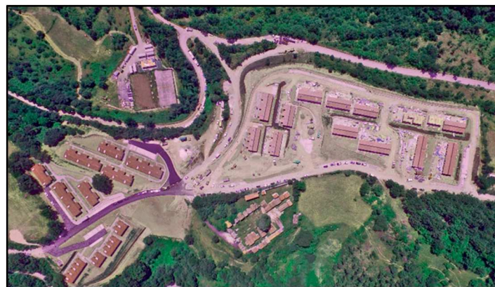
Fig.95 - Area destinata all'installazione delle S.A.E. ad Accumoli -
