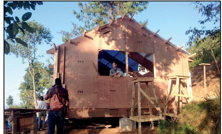
Fig.168 - Avanzamento lavori e fasi di cantiere del progetto Charikot Veneer House, Dolakha (Nepal) 2015 -
