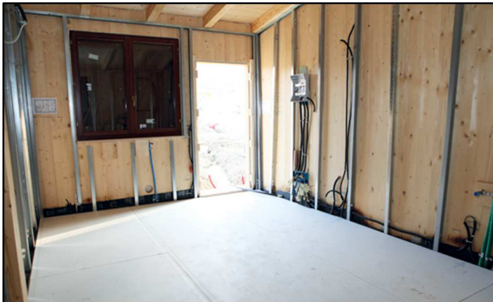
Fig.81 - Avanzamento lavori M.A.P. a Rocca di Cambio -
