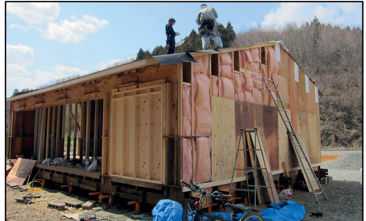
Fig.148 - Avanzamento lavori e fasi di cantiere del progetto Veneer House di Minamisanriku, Miyagi (Giappone) 2012 -
