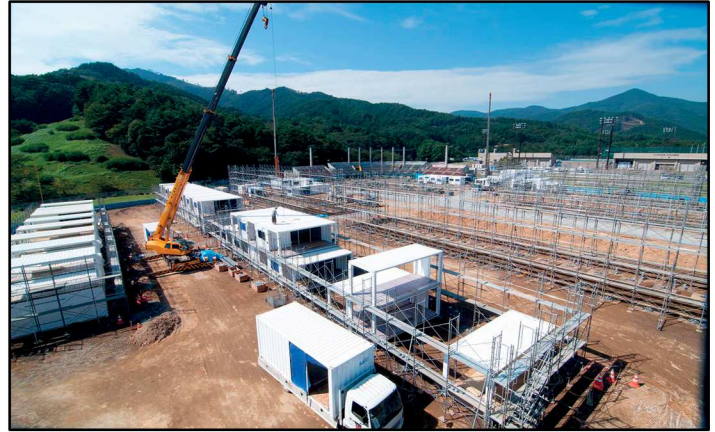
Fig.53 - Fasi di cantiere, Onagawa Container Temporary Housing -
