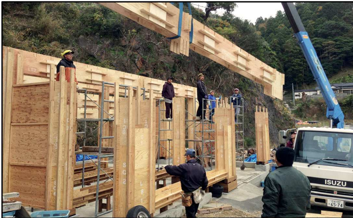
Fig.154 - Avanzamento lavori e fasi di cantiere del progetto Veneer House di Maeamihama, Miyagi (Giappone) 2013 -
