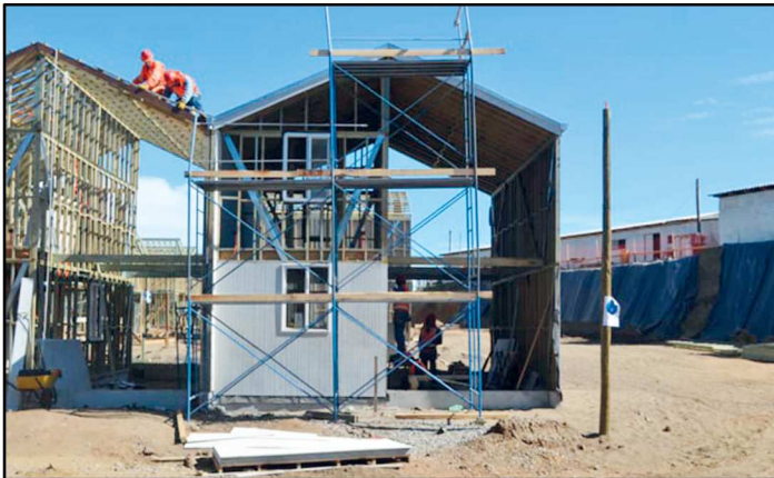
Fig.36 - Avanzamento lavori e fasi di cantiere -
