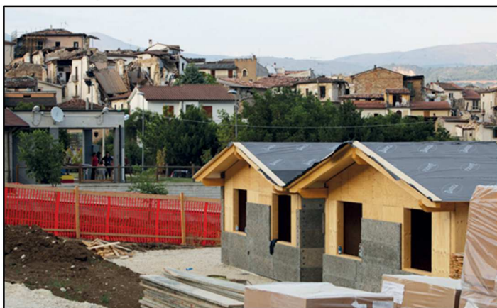
Fig.77 - Avanzamento lavori M.A.P. di Villa Sant'Angelo -
