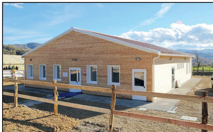
Fig.128 - Il Modulo scolastico provvisorio di Cittareale in costruzione -
