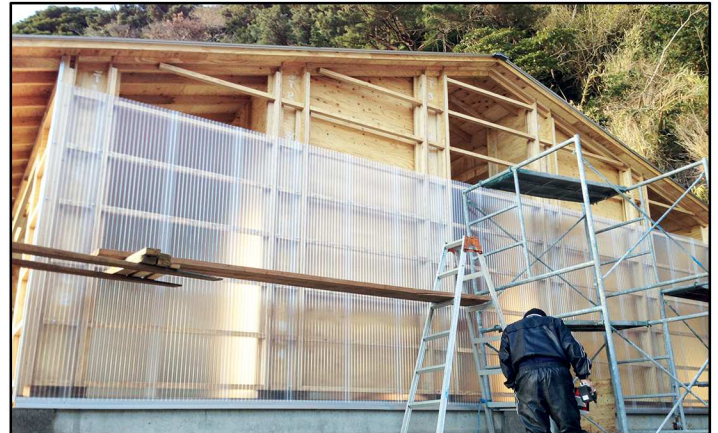
Fig.157 - Avanzamento lavori e fasi di cantiere del progetto Veneer House di Maeamihama, Miyagi (Giappone) 2013 -
