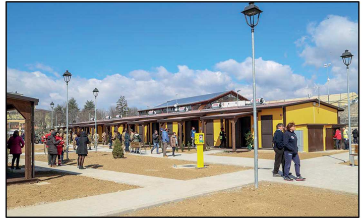
Fig.112 - S.A.E. realizzate ad Amatrice (Campo0) -
