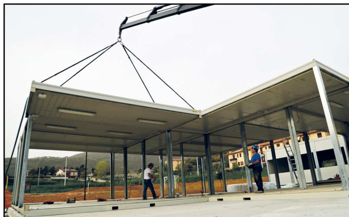
Fig.127 - Il Modulo scolastico provvisorio di Norcia in costruzione -
