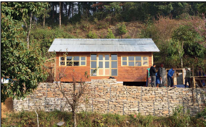
Fig.174 - Avanzamento lavori e fasi di cantiere del progetto Charikot Veneer House, Dolakha (Nepal) 2015 -
