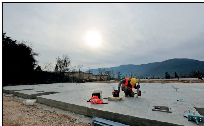
Fig.97 - Avanzamento lavori delle S.A.E. di Norcia -
