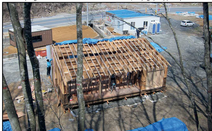
Fig.144 - Avanzamento lavori e fasi di cantiere del progetto Veneer House di Minamisanriku, Miyagi (Giappone) 2012 -
