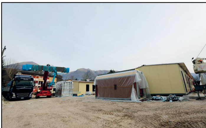
Fig.101 - Avanzamento lavori delle S.A.E. di Norcia -
