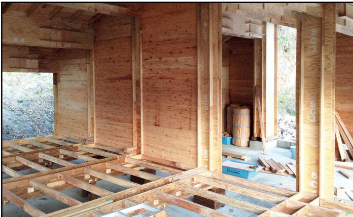
Fig.158 - Avanzamento lavori e fasi di cantiere del progetto Veneer House di Maeamihama, Miyagi (Giappone) 2013 -
