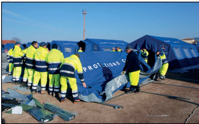
Fig.64 - Operatori della Protezione Civile in fase di allestimento tende -
