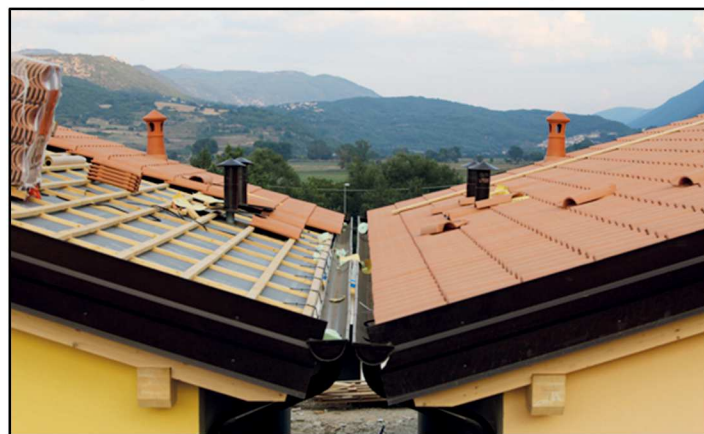
Fig.78 - Avanzamento lavori M.A.P. di Villa Sant'Angelo -
