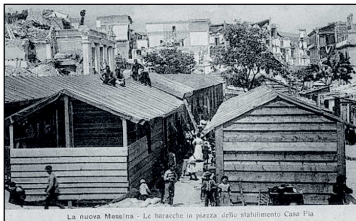
Fig.66 - Le baracche in piazza dello stabilimento Casa Pia (Messina) -
