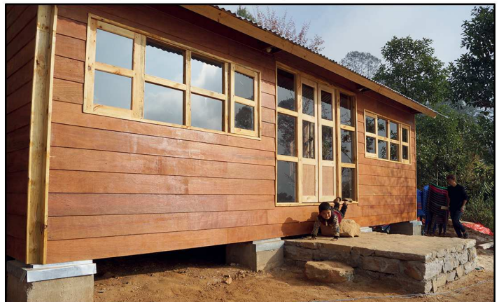
Fig.175 - Avanzamento lavori e fasi di cantiere del progetto Charikot Veneer House, Dolakha (Nepal) 2015 -
