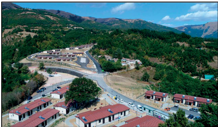
Fig.96 - Area destinata all'installazione delle S.A.E. ad Accumuli -
