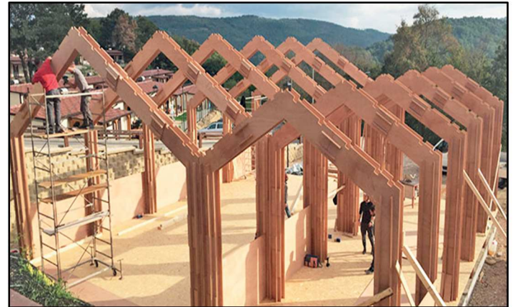
Fig.181 - Avanzamento lavori e fasi di cantiere del progetto H.E.L.P.6.5 -
