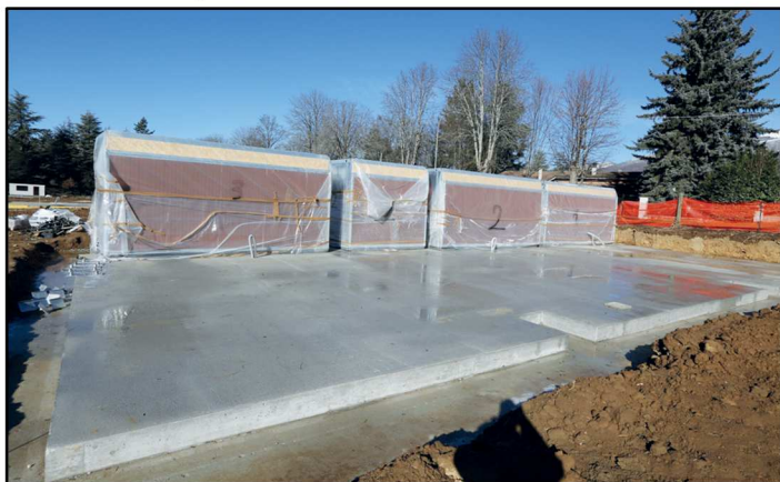
Fig.109 - S.A.E. realizzate ad Amatrice (Campo0)-
