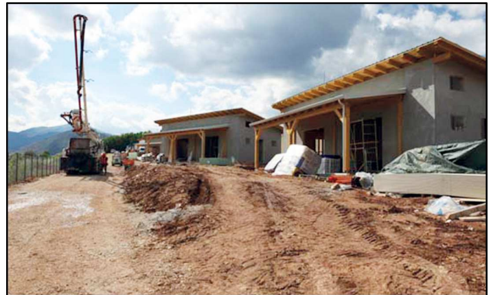
Fig.82 - Avanzamento lavori M.A.P. a Coppito-
