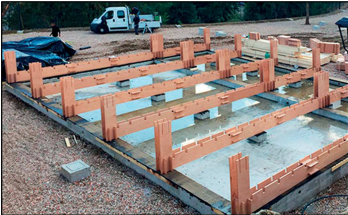
Fig.180 - Avanzamento lavori e fasi di cantiere del progetto H.E.L.P.6.5 -
