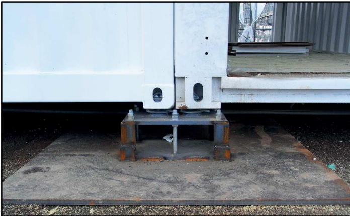
Fig.58 - Particolare dell'aggancio a terra della struttura -
