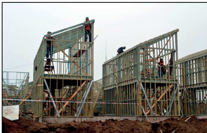
Fig.34 - Avanzamento lavori e fasi di cantiere -
