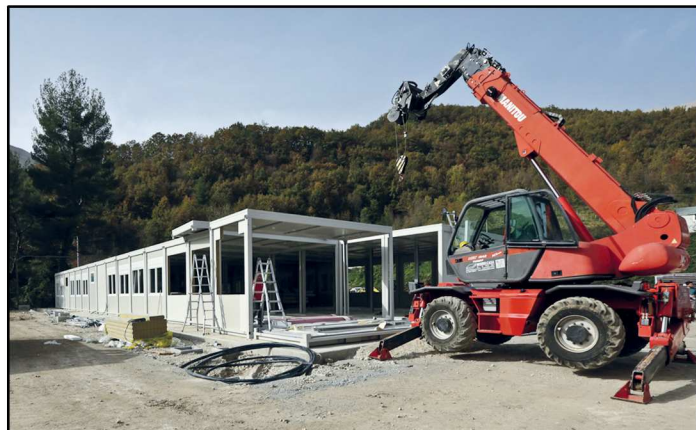
Fig.126 - Il Modulo scolastico provvisorio di Arquata in costruzione -
