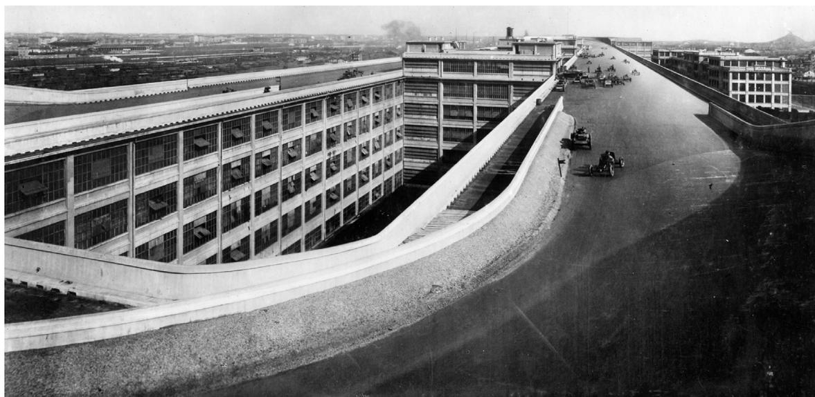
1923 CURVA PARABOLICA DELLA PISTA DI COLLAUDO SOPRAELEVATA
