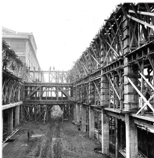
1925 AMPLIAMENTO LATO NORD. IN POSA LE MAESTRANZE EDILI, LE STRUTTURE IN CEMENTO ARMATO SONO DISPOSTE, I CASSERI E GLI ELEMENTI DI TENUTA SONO GIÀ RIMOSI AL PIANO TERRENO.
