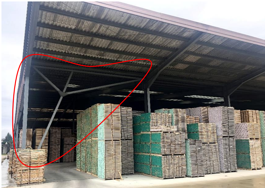
Figura 3.11 – Lato iniziale che impossibilita l'applicazione efficace di una scaffalatura
