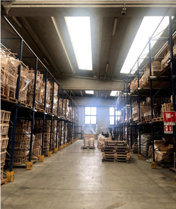
Figura 3.16 – Scaffalatura Drive-In già adottata in un magazzino dimensionalmente uguale al E
