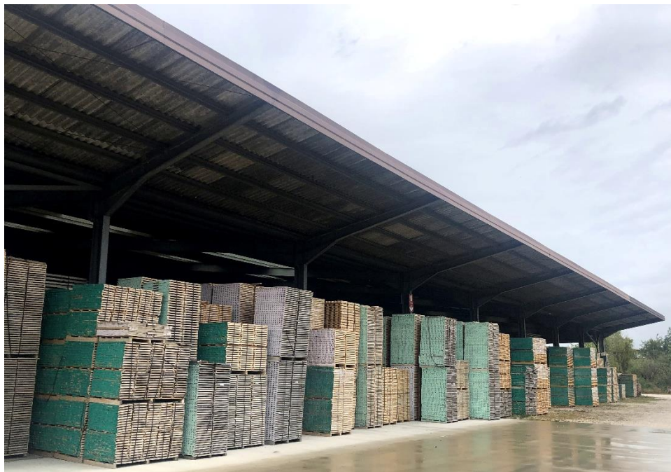
Figura 3.6 – Magazzino D in Šuma con assenza di pareti laterali per favorire l'areazione al legno.
