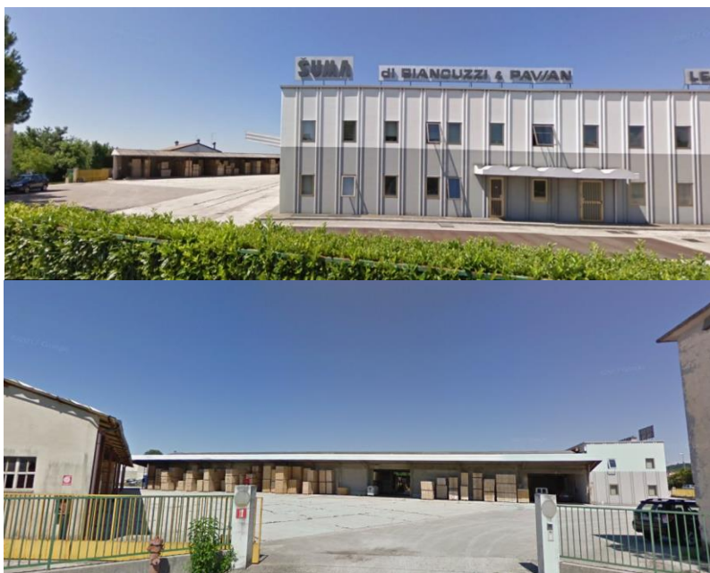
Figura 2.3 – Magazzini C1 e C2, aree di stoccaggio coperte da una tettoia per areazione.
