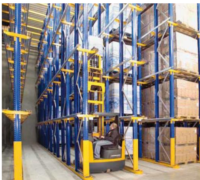
Figura 3.3 – Scaffalatura Drive-in con fine dei canali che coincide con la parete del magazzino.
