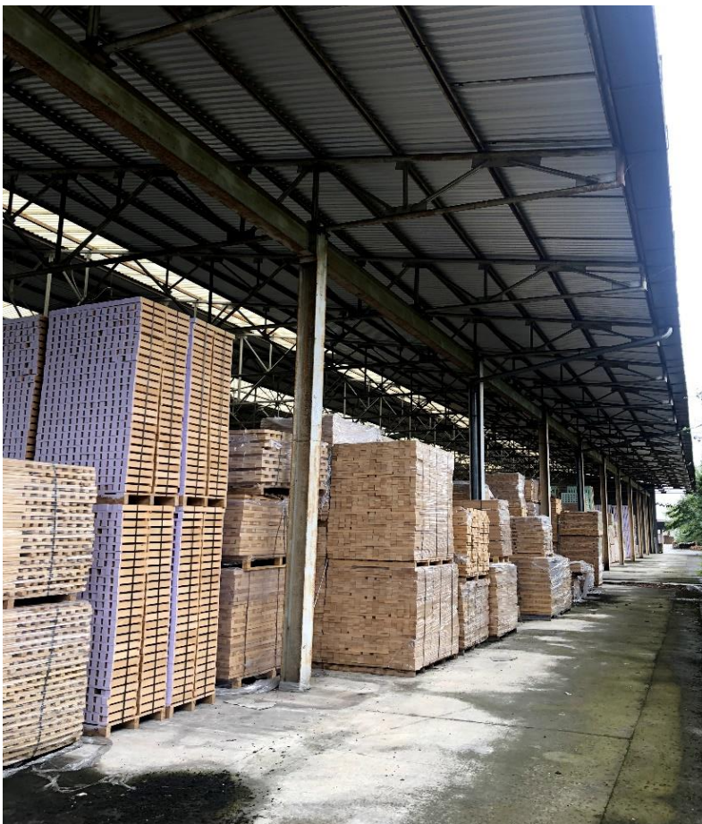
Figura 2.1 – Esempio di magazzino coperto con assenza di parete laterale per permettere l'areazione ai semilavorati.
