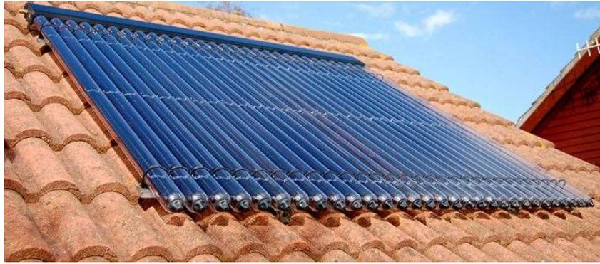
Figura 2.42 Collettori a tubi sottovuoto installati su un tetto [13]
