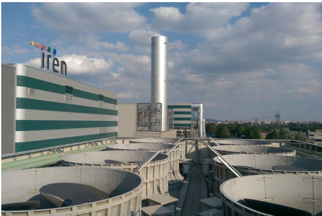
Figura 9 - Centrale termoelettrica IREN Torino Nord [8]
