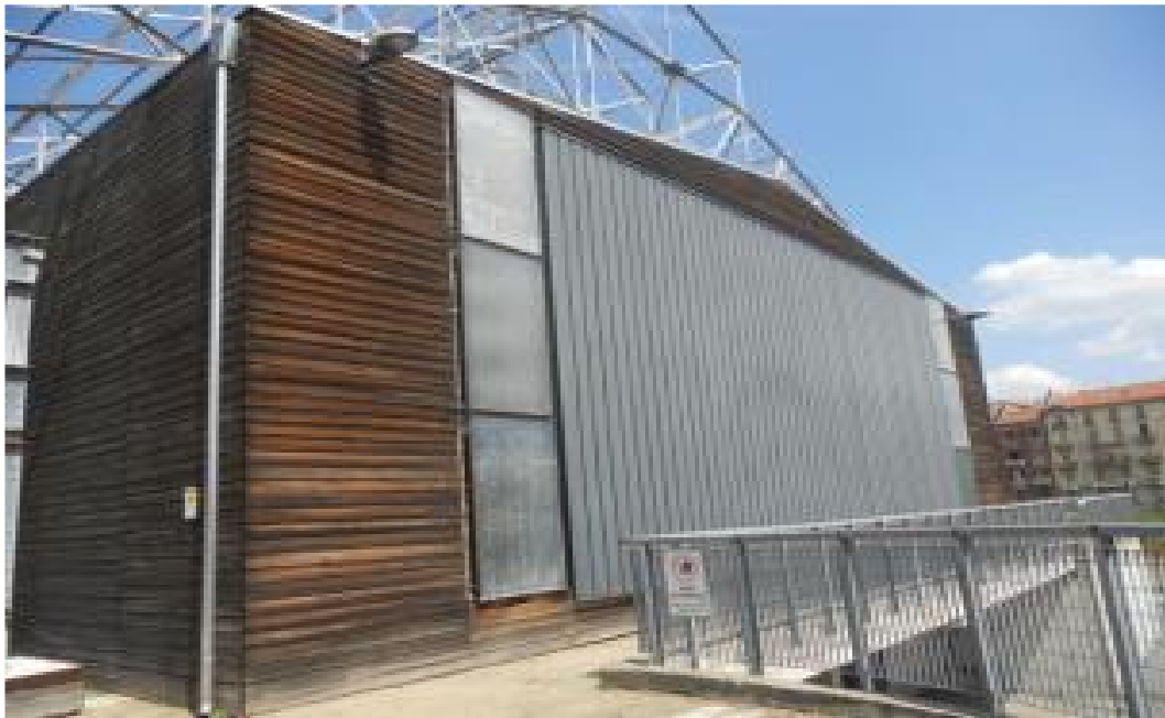
Figura 6 - Centro servizi prospetto Sud con collettori solari e Solarwall [4]
