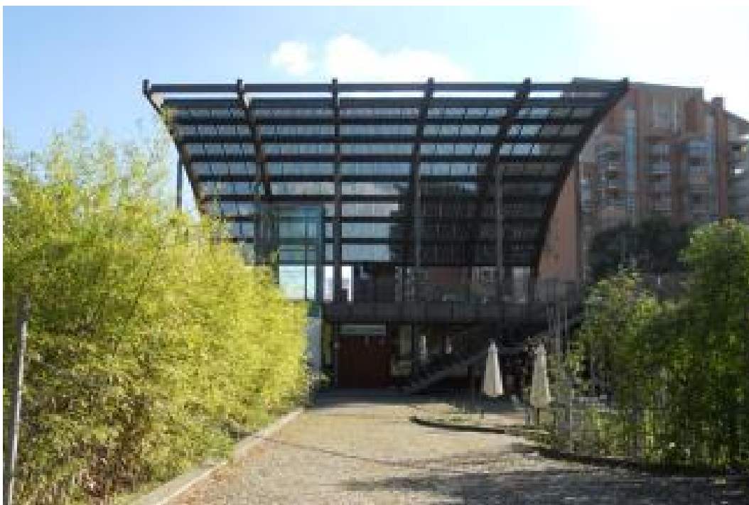
Figura 5 - Vela fotovoltaica [4]
