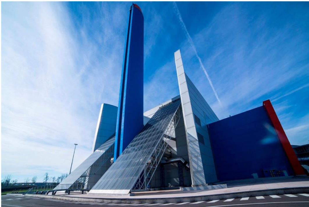
Figura 10 - Termovalorizzatore cogenerativo TRM [9]
