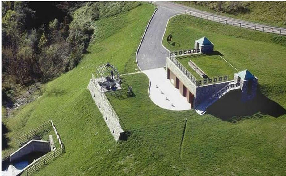
*Figura 2-7: centrale idroelettrica del Noiaris: particolare su edificio turbine e opera di rilascio delle acque nel torrente Bùt. [7]*
