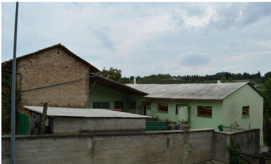
Figura 5-28: dettaglio del rimessaggio agricolo con tetto in Eternit. [Fotografia propria]
