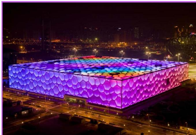
Fig. 3.1 - Centro acquatico di Pechino. Lo space filling ha permesso di risparmiare sui costi e di scegliere come materiale l'Etilene TetrafluoroEtilene
