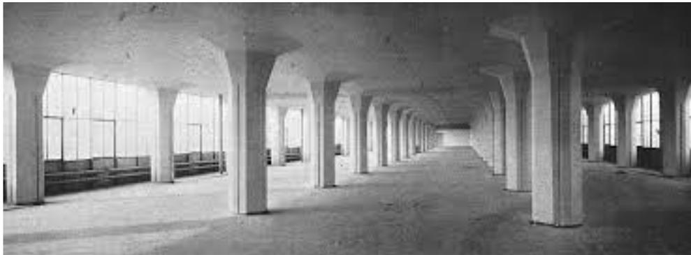
Fig. 2.11 - Solaio a fungo
