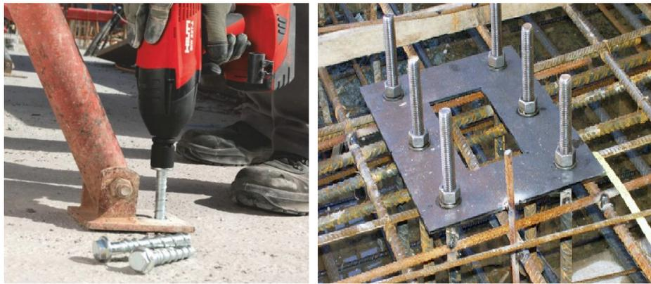
*Fig. 6.7 - A sinistra Ancoranti ad Alte Prestazioni Hilti, a destra esempio di tirafondi all'interno della rete elettrosaldata prima del getto di calcestruzzo*
