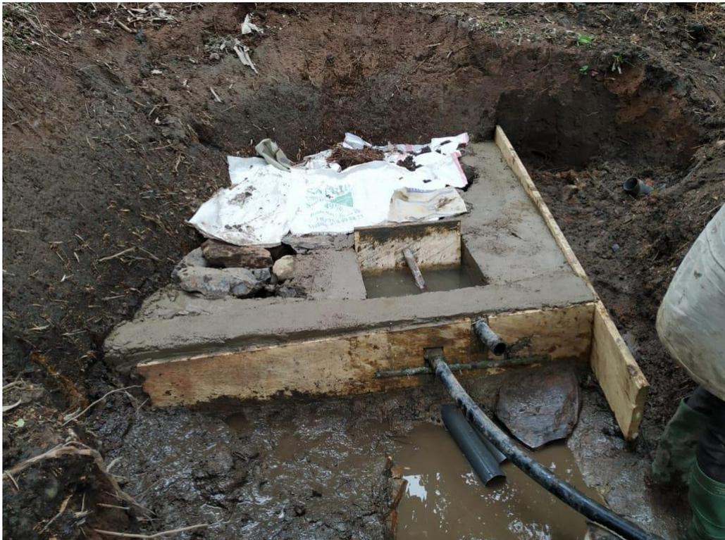
*Figura 3.2.2a – Opera di presa in fase di costruzione*
