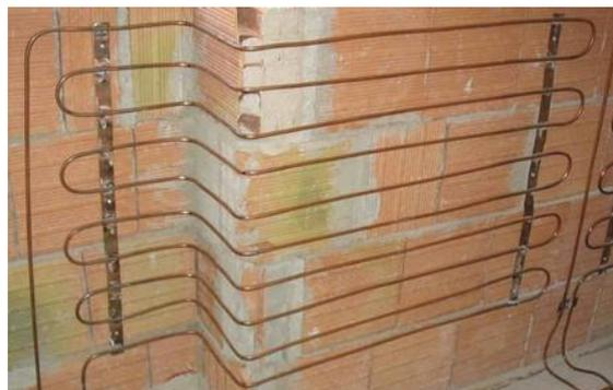
Figura 33- Installazione a parete - Sinistra: struttura di parete verticale con pannello radiante prefabbricato tipo; Destra: - Posa in loco di un sistema a pannelli radianti a parete fissati attraverso l'uso di guide
