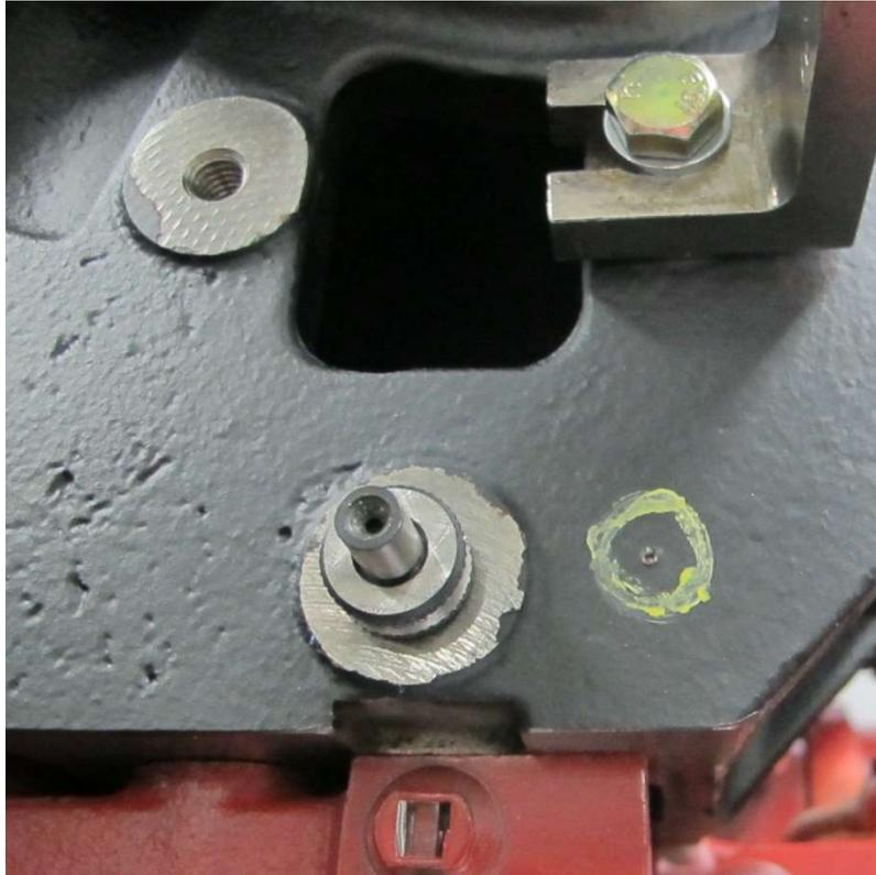
*Figura 3.3-Inserto filettato (a sinistra), segno da punzone centrale (a destra)*
