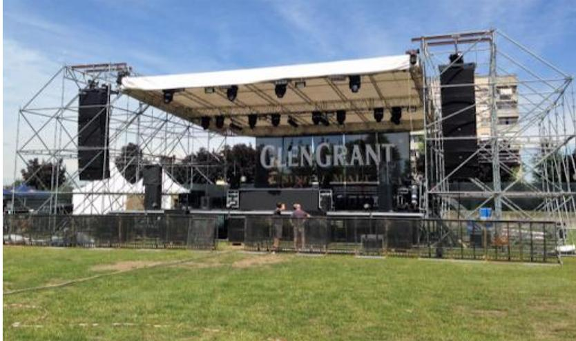
*Figura 5: palco in elementi tralicciati di alluminio*
