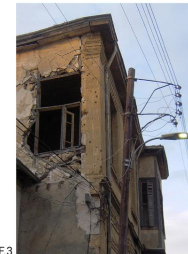
F.3 Muro a telaio esterno connesso al muro della facciata principale in pietra.
