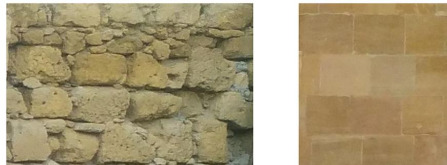
Figura 102. Calcarenite in conci sbozzati (a sinistra), calcarenite in conci squadri (a destra).
