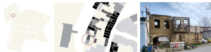
Figura 82. Quartiere di Arabahmet: la condizione di rudere dell'edificio rende evidente la presenza di due corpi costruiti in periodi diversi.
