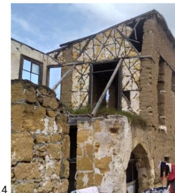
F.4 Muro a telaio interno connesso ai muri in mattoni di fango perimetrali e collegato con la tecnica dell'imantosis all'altezza dell'apertura.
