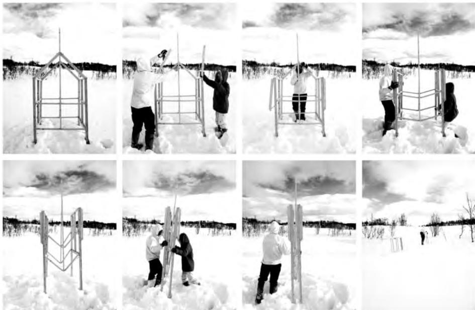
Processi per la ripiegatura della struttura.
