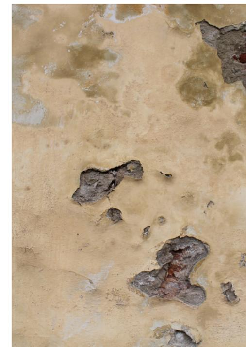
Figura 82: Foto scattata durante un sopralluogo, 4 giugno 2020, dettaglio del distacco e del rigonfiamento dell'intonaco, sul prospetto Ovest della manica Est
