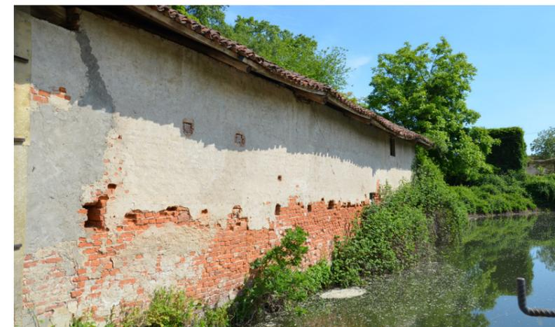
Figura 79: Foto scattata durante un sopralluogo, 4 giugno 2020, dettaglio della presenza di vegetazione, in questo caso arrampicante, sul prospetto Ovest della manica Ovest
