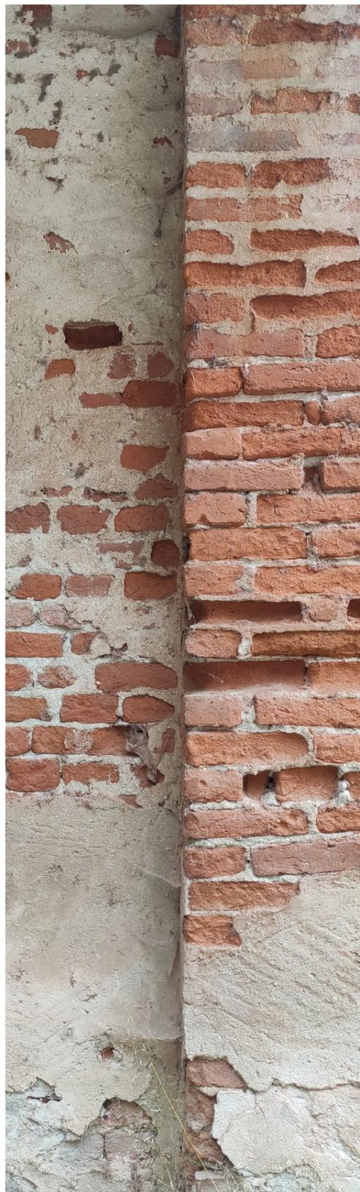
Figura 80: Foto scattata durante un sopralluogo, 4 giugno 2020, erosione su laterizio, rigonfiamento dell'intonaco e deposito superficiale, sul prospetto Sud della manica Est
