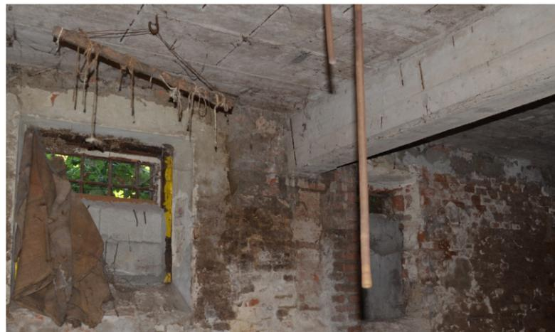
Figura 16: Foto scattata durante un sopralluogo, maggio 2019, interno cantina dettaglio finestre e soletta in calcestruzzo armato con perno pilastro centrale, risultato degli ultimi rimaneggiamenti
