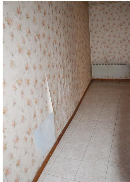
Figura 64: Foto scattata durante un sopralluogo, maggio 2019, interno abitazione del mugnaio, dettaglio distacco della carta da parati
