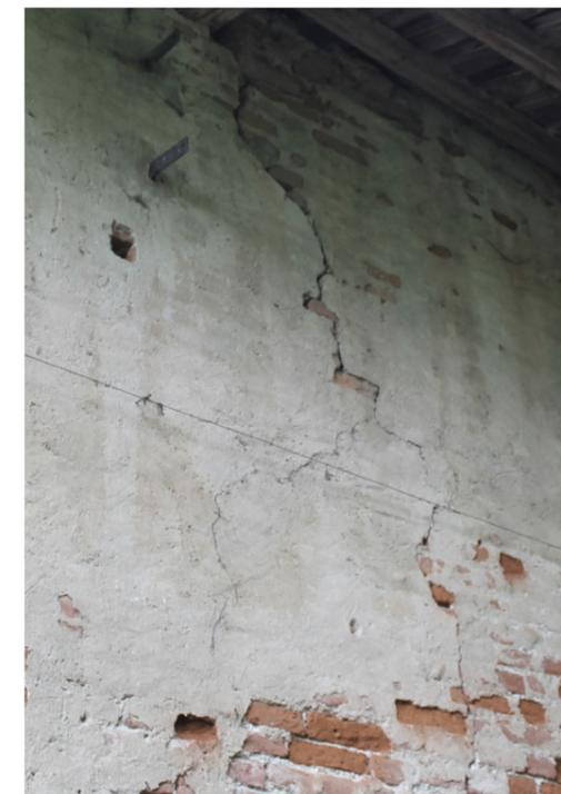
Figura 86: Foto scattata durante un sopralluogo, 4 giugno 2020, fessurazione non passante, prospetto Sud della manica Est
