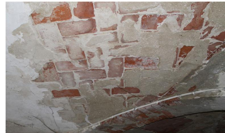
Figura 91: Foto scattata durante un sopralluogo, 4 giugno 2020, distacco dell'intonaco di calce aerea dal soffitto voltato, interno manica Ovest dove si possono notare i mattoni disposti a lisca di pesce
