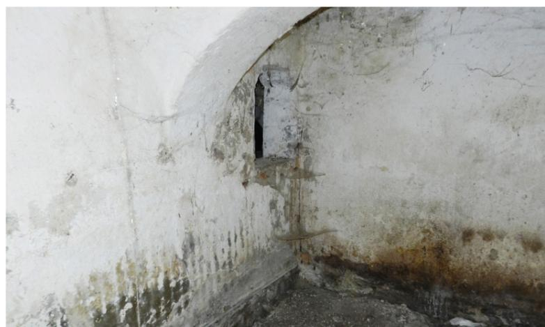
Figura 94: Foto scattata durante un sopralluogo, 4 giugno 2020, degradi derivanti dall'umidità, interno manica Ovest
