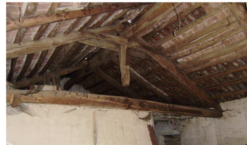
Figura 62: Foto scattata durante un sopralluogo, novembre 2013, dettaglio della copertura in capriate lignee alla piemontese, listelli e pianelle
