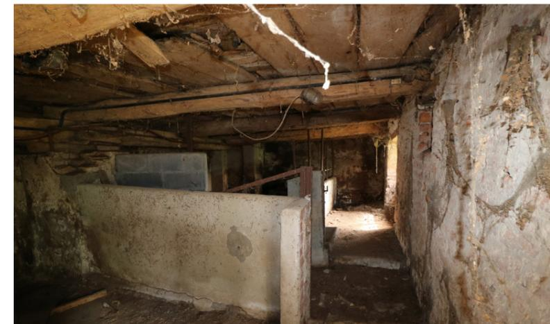
Figura 49: Foto scattata durante un sopralluogo, maggio 2019, interno della canapaia, particolare della puntellatura della copertura pericolante
