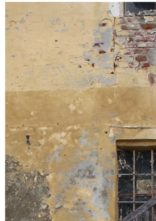
Figura 85: Foto scattata durante un sopralluogo 4 giugno 2020, alterazione cromatica, sul prospetto Ovest della manica Est
