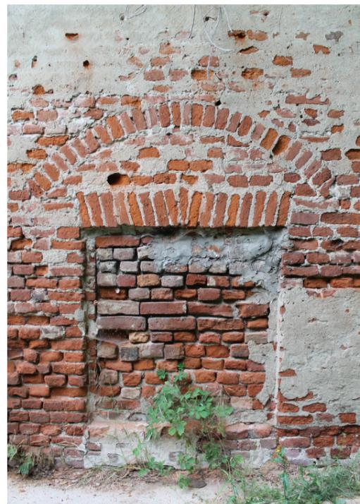
Figura 83: Foto scattata durante un sopralluogo, 4 giugno 2020, apposizione incompatibile con malta cementizia, dilavamento dei giunti, erosione del laterizio presenti sul prospetto Sud della manica Est
