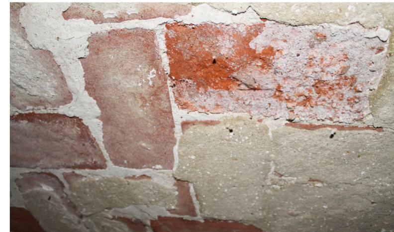
Figura 92: Foto scattata durante un sopralluogo, 4 giugno 2020, efflorescenza su laterizio, interno manica Ovest
