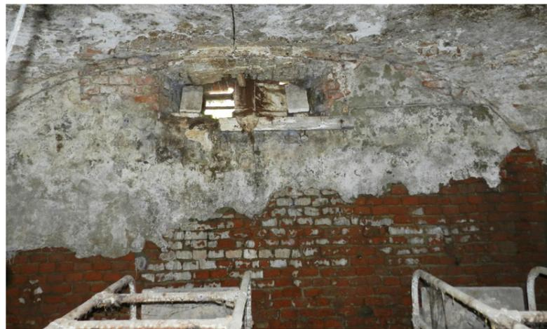
Figura 88: Foto scattata durante un sopralluogo, 4 giugno 2020, dettaglio della bocca di lupo otturata della manica Est, si possono notare una linea netta del distacco dell'intonaco, una presenza rilevante di depositi superficiali e la presenza di micro organismi sul soffitto voltato
