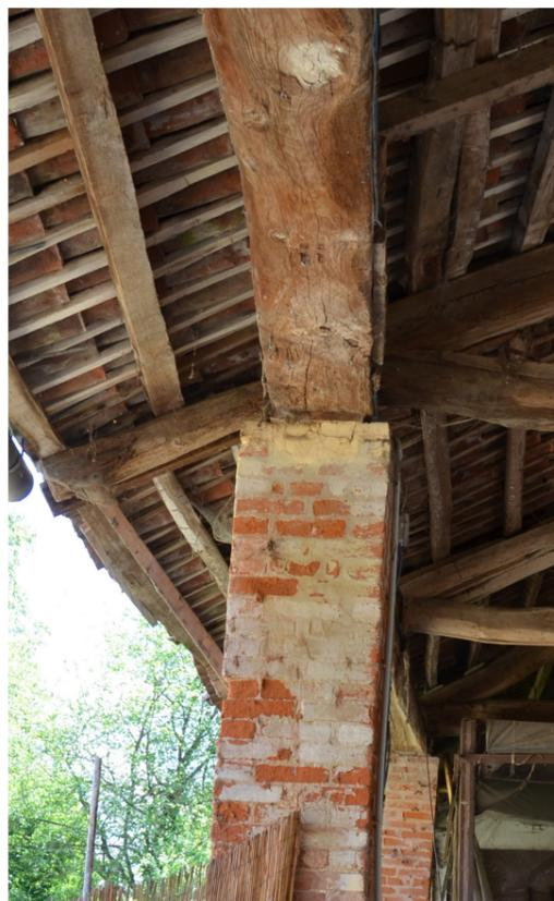
Figura 29: Foto scattata durante un sopralluogo, maggio 2019, particolare del pilastro in muratura, su cui sono osservabili evidenti segni di degrado dei laterizi
