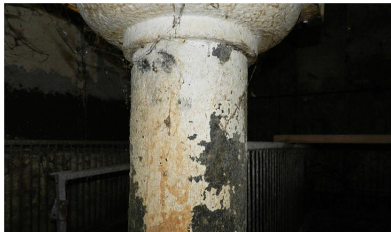
Figura 93: Foto scattata durante un sopralluogo, 4 giugno 2020, distacco da lapideo, pilastro portante, interno manica Est
