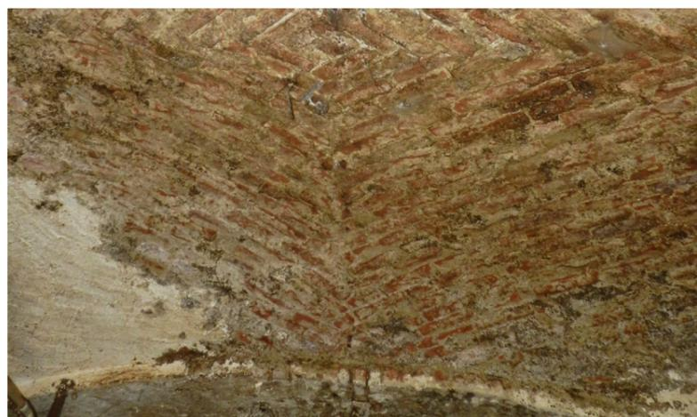
Figura 95: Foto scattata durante un sopralluogo, 4 giugno 2020, deposito superficiale sulla volta a vela dell' interno della manica Est
