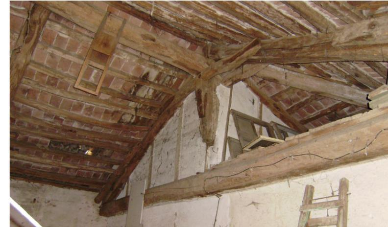
Figura 60: Foto scattata durante un sopralluogo, novembre 2013, dettaglio della copertura in capriate lignee alla piemontese, listelli e pianelle
