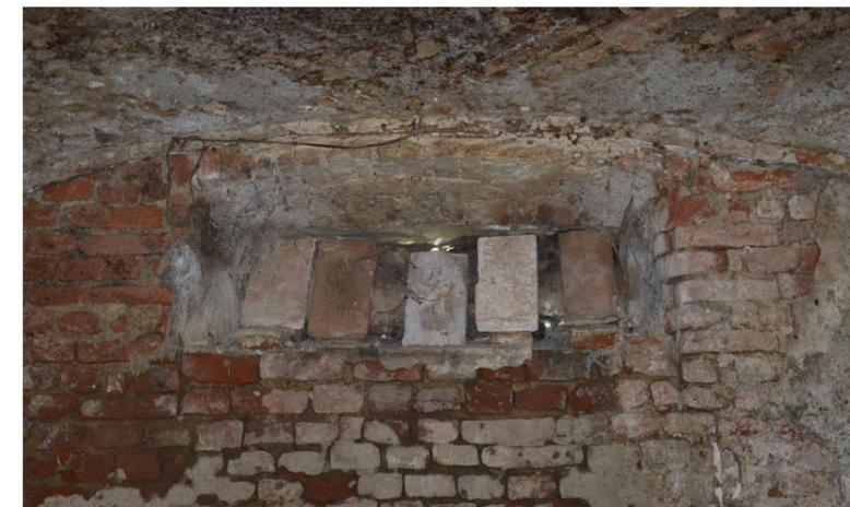
Figura 2: Foto scattata durante un sopralluogo, maggio 2019, particolare della bocca di lupo tamponata, fronte est
