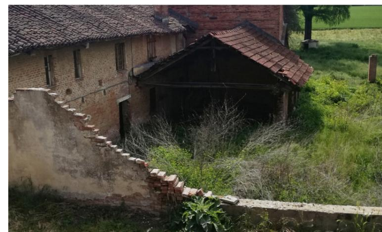
Figura 43: Foto scattata durante un sopralluogo, maggio 2019, particolare della copertura con le tegole marsigliesi
