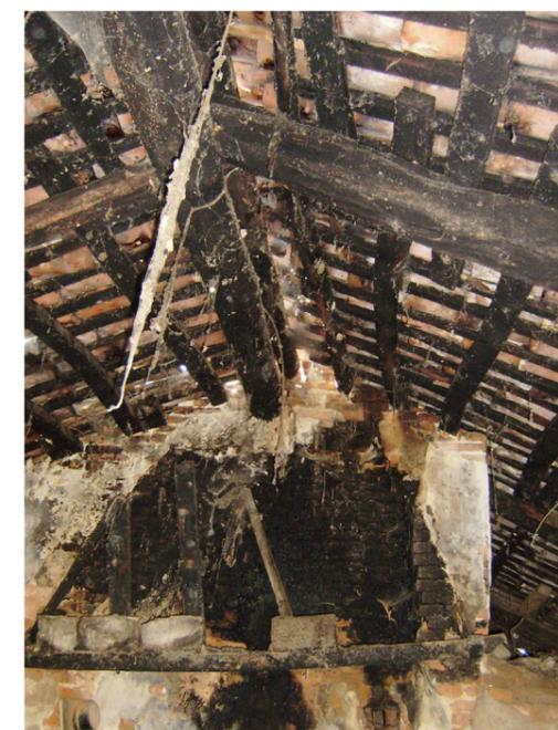
Figura 56: Foto scattata durante un sopralluogo, novembre 2013, interno dell'antica fornace, particolare dell'orditura della copertura in travi e listelli, carbonizzati dall'incendio
