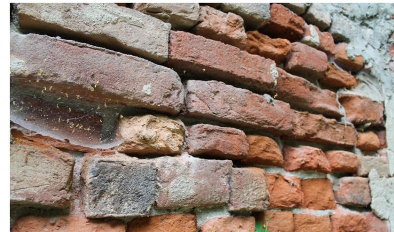
Figura 78: Foto scattata durante un sopralluogo, 4 giugno 2020, dettaglio del dilavamento dei giunti di malta, prospetto Est manica Est
