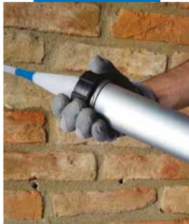
Fissaggio del tool di iniezione avvitando la ghiera alla pistola
