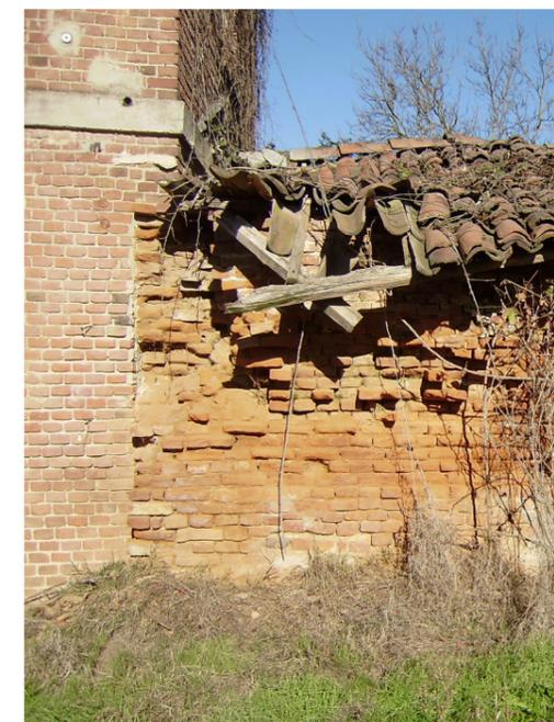
Figura 55: Foto scattata durante un sopralluogo, novembre 2013, particolare del mancato ammassamento dei due fabbricati
