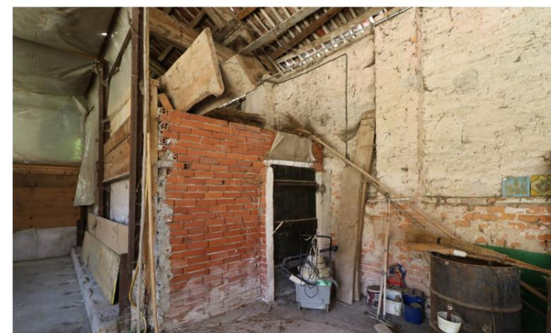
Figura 31: Foto scattata durante un sopralluogo, maggio 2019, dettaglio tramezzature in blocchetti forati non portanti
