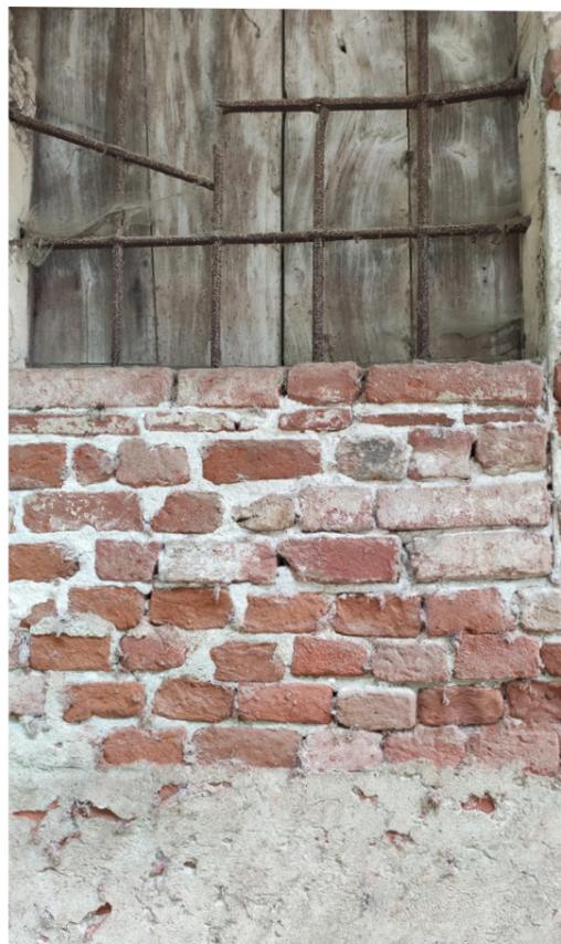
Figura 84: Foto scattata durante un sopralluogo, 4 giugno 2020, dettaglio dell'ossidazione delle inferriate, sul prospetto Est della manica Est
