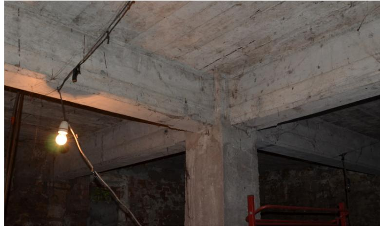
Figura 15: Foto scattata durante un sopralluogo, maggio 2019, interno cantina, dettaglio del pilastro centrale in calcestruzzo armato e della soletta
