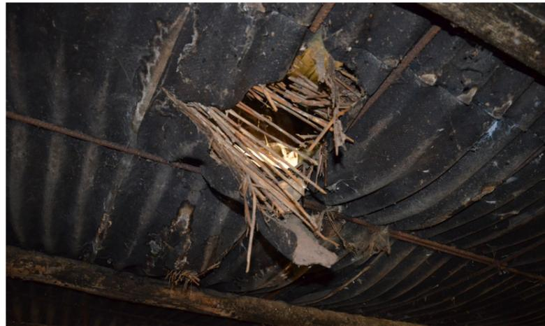
Figura 11: Foto scattata durante un sopralluogo, maggio 2019, dettaglio dissenso orizzontamento
