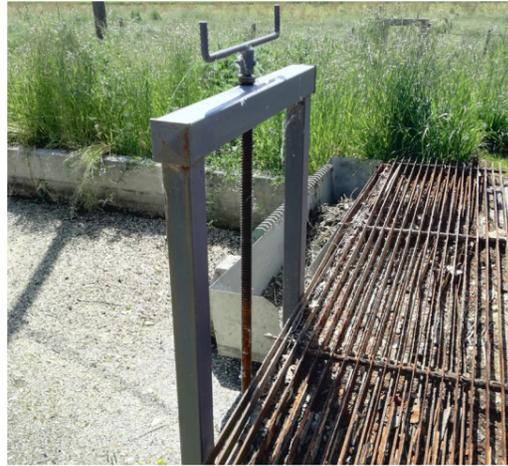
Figura 29: Foto scattata durante un sopralluogo, maggio 2019, dettaglio paratoia, che regola il corso del torrente
