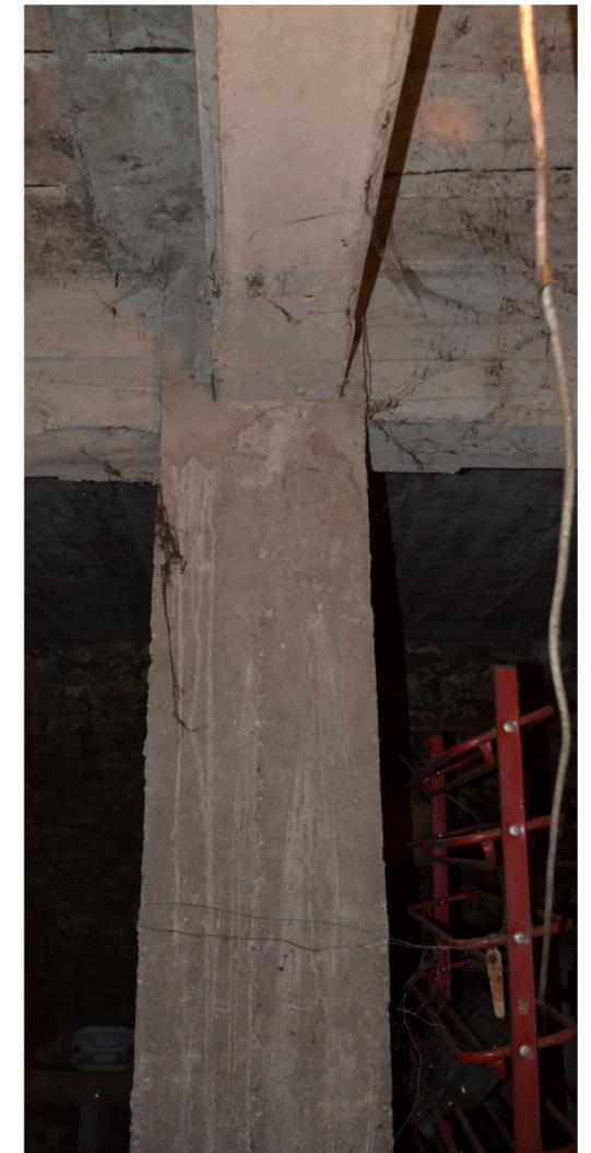
Figura 14: Foto scattata durante un sopralluogo, maggio 2019, interno cantina, dettaglio pilastro centrale in cemento armato collocato al centro della stanza
