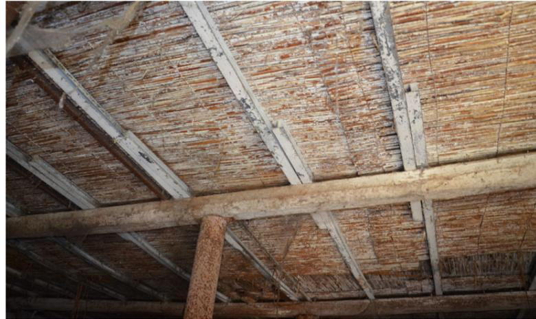
Figura 10: Foto scattata durante il sopralluogo del maggio 2019, dettaglio orizzontamento con coibentazione in canniccio
