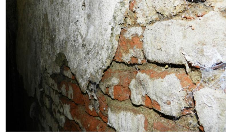
Figura 90: Foto scattata durante un sopralluogo, 4 giugno 2020, dilavamento dei giunti, interno manica Est
