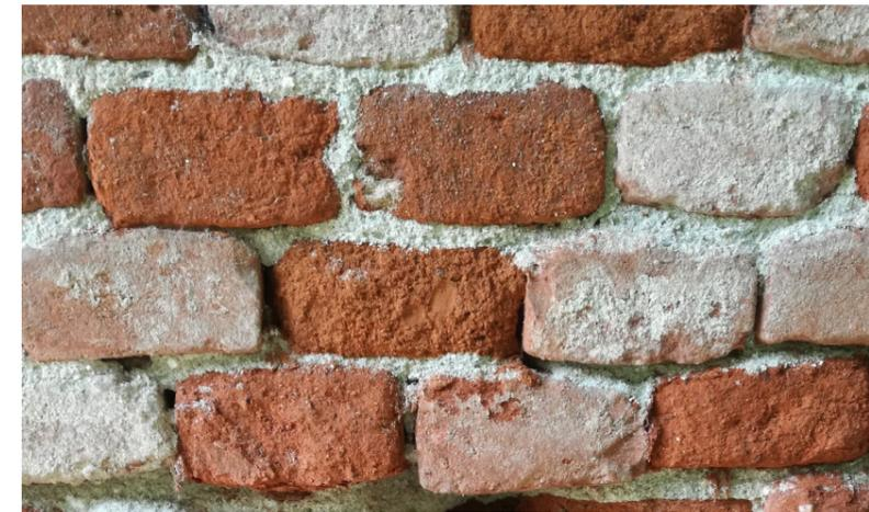
Figura 77: Foto scattata durante un sopralluogo, 4 giugno 2020, dettaglio della polverizzazione dei mattoni, prospetto Ovest della manica Ovest
