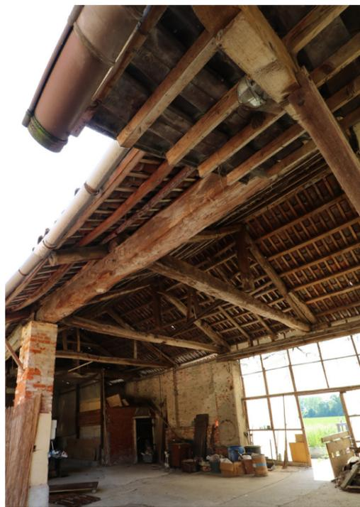
Figura 34: Foto scattata durante un sopralluogo, maggio 2019, vista della tettoia, dettaglio tamponatura in plastica di connessione tra il portico e il ponte in pietra
