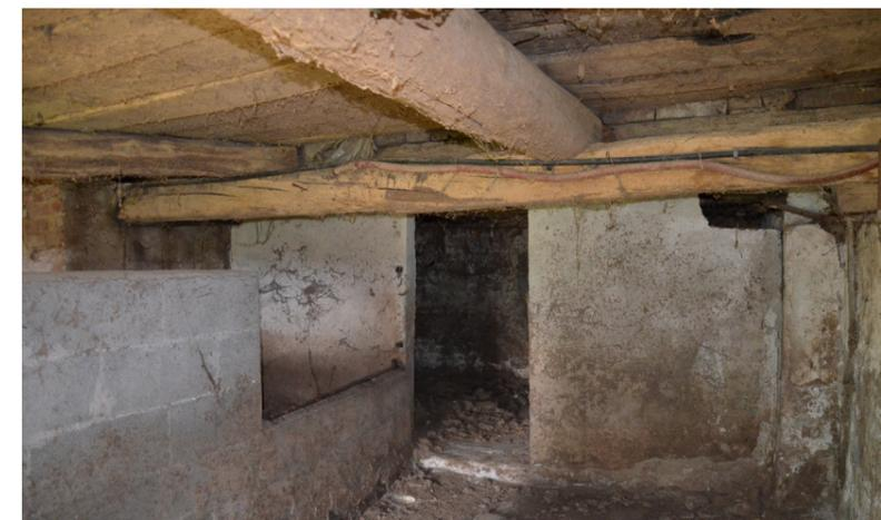
Figura 50: Foto scattata durante un sopralluogo, maggio 2019, interno della canapaia, particolare delle orditure lignee e bassi muri in blocchi di cemento su cui è stato impuntellato il tetto per evitarne il crollo
