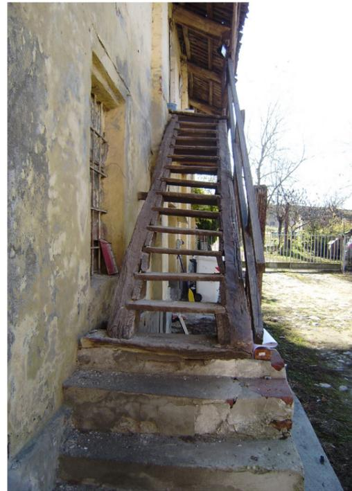
Figura 58: Foto scattata durante un sopralluogo, novembre 2013, dettaglio scala lignea di accesso al piano primo
