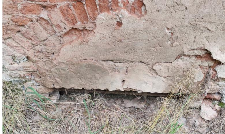
Figura 87: Foto scattata durante un sopralluogo, 4 giugno 2020, dettaglio della bocca di lupo otturata, sul prospetto Est della manica Est
