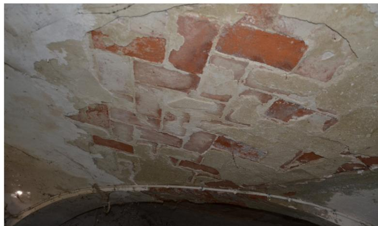
Figura 6: Foto scattata durante il sopralluogo del maggio 2019, dettaglio della volta con mattoni di piatto posizionati a lisca di pesce, manica Ovest
