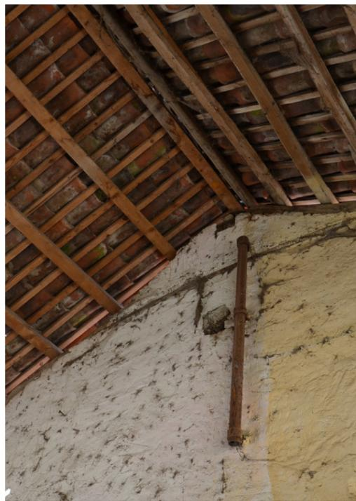
Figura 33: Foto scattata durante un sopralluogo, maggio 2019, dettaglio solaio di copertura in coppi alla piemontese
