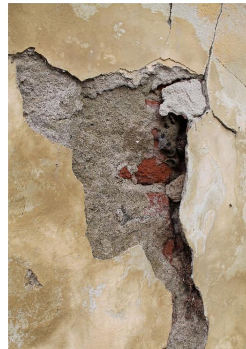
Figura 81: Foto scattata durante un sopralluogo, 4 giugno 2020, dettaglio del distacco dell'intonaco, sul prospetto Ovest della manica Est
