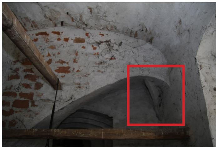
fig. h: traccia della presenza di una volta a crociera nella stanza sotto il pavimento della copertura
