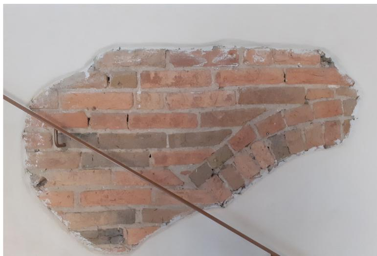
Fig. 5 Arco visibile nel vano scala
