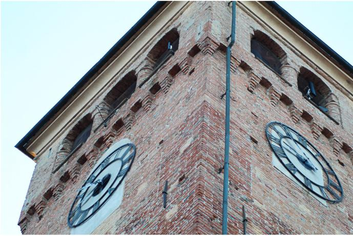
fig. m: evidente traccia delle diverse unità di fase (incrocio tra lato sud e lato est)
