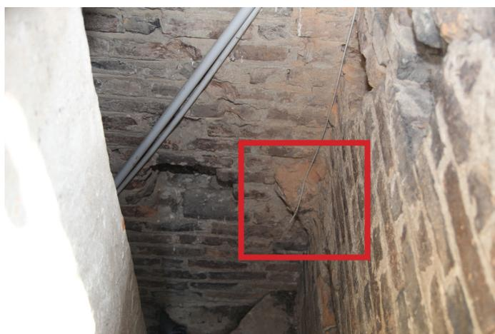
fig. k: traccia della presenza di una volta a crociera nella stanza sotto il pavimento della copertura
