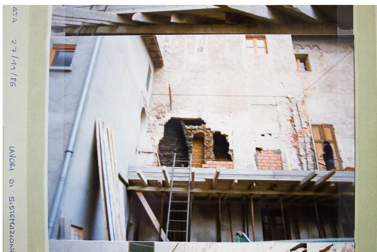
Fig. 1 Lavori per la realizzazione del balcone e della relativa copertura<sup>3</sup>
