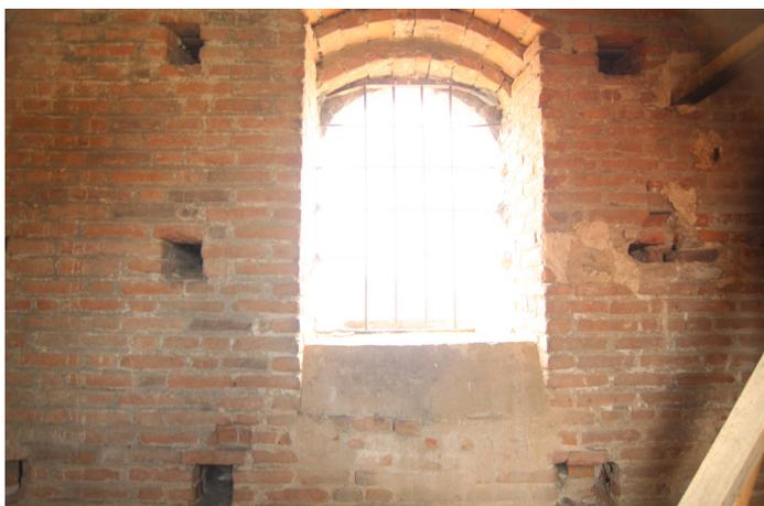
fig. c: apertura verso sud non in fase con il solaio
