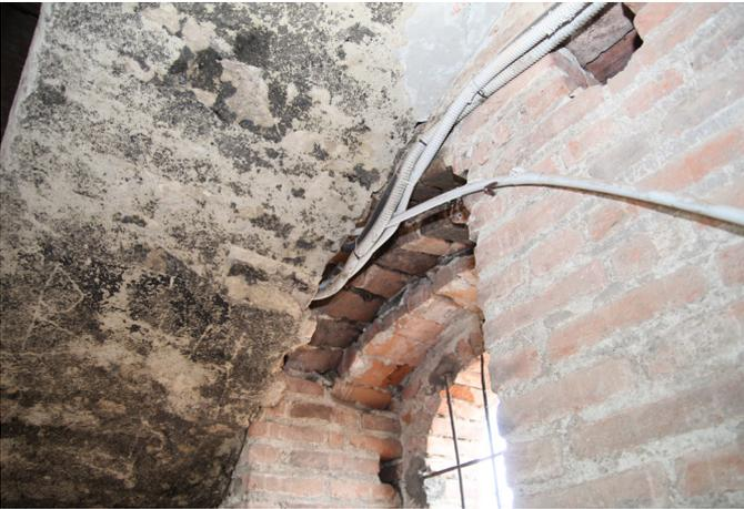
fig. o: evidente segno delle diverse unità di fase nella scala in muratura che si appoggia alla muratura (lato nord)
