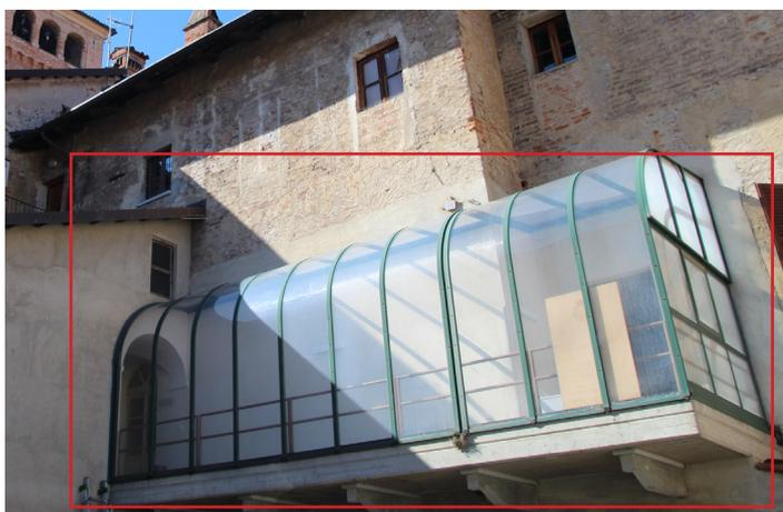
Fig. 3 Copertura balcone esterno
