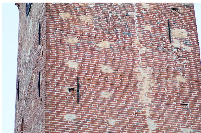
fig. i: lato ovest della torre con evidenti segni delle delle buche puntaie
