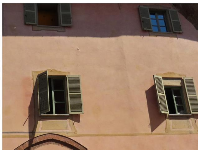
fig. 6 Evidenti segni di tamponatura di un arco a sesto acuto nella zona ovest del prospetto sud
