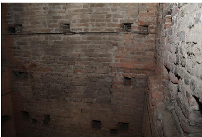
fig. g: evidenti segni di due unità edilizie diverse sul lato est all'interno della torre
