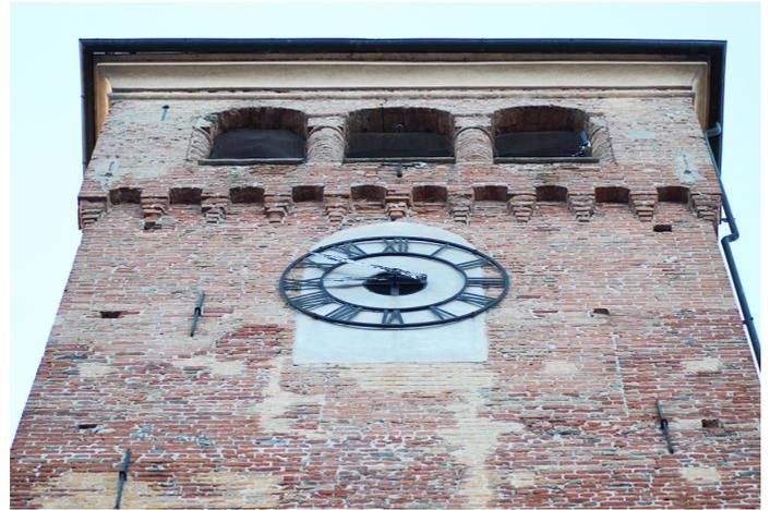
fig. n: evidenti tracce delle diverse unità di fase (lato sud)
