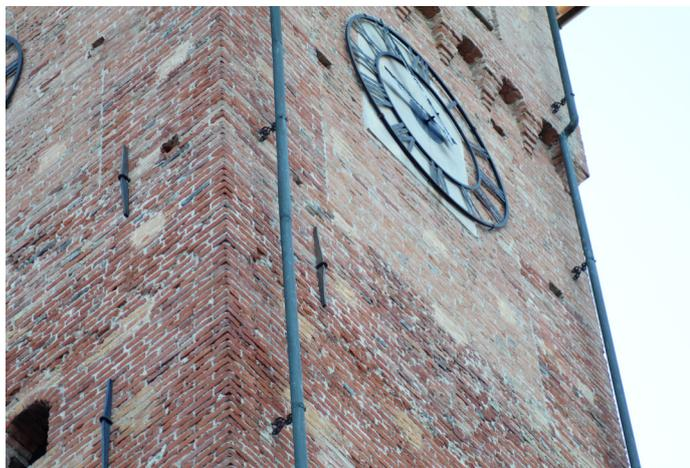
fig. w: differenza tra la tessitura muraria della UF1 e della UF2 sul prospetto est
