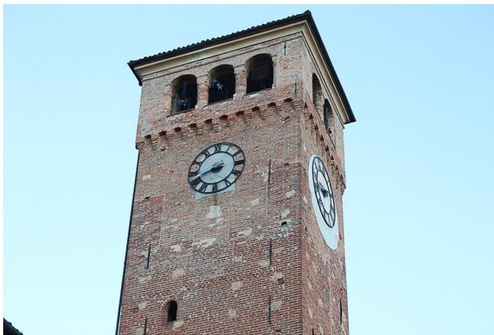
fig. a: lato nord della torre con evidenti segni di disomogeneità nella tessitura muraria, indice delle diverse unità di fase
