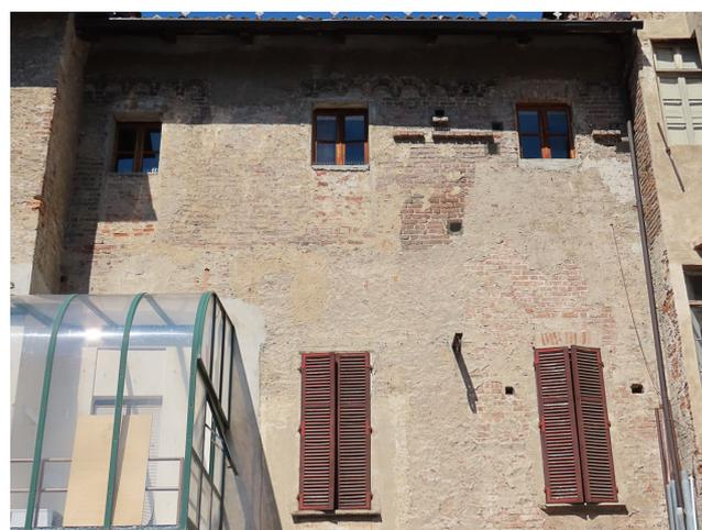
fig. 17 (Termogramma 3) Differenza nella tipologia di muratura
