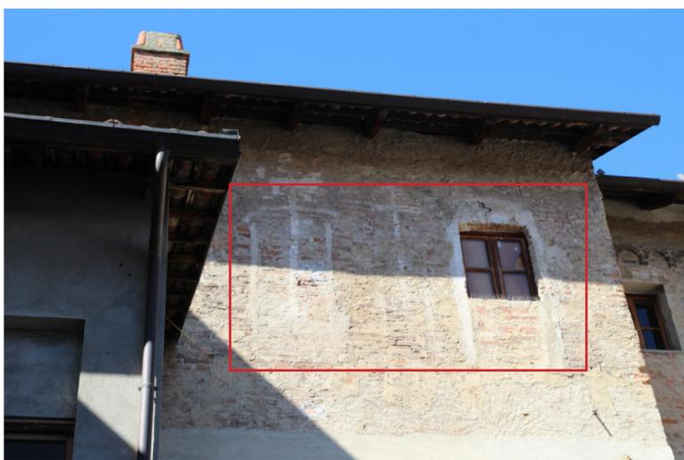
Fig 18 Segni di tamponature di due porte finestre al piano secondo
