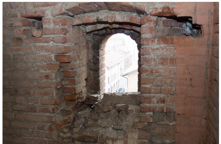
fig. r: apertura verso nord, non in fase con la scala in muratura
