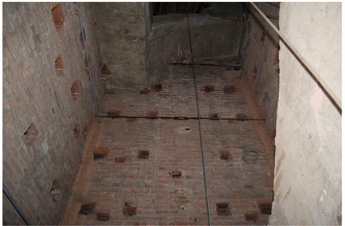
fig. v: buche pontai sul lato ovest all'interno della torre
