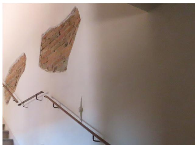
fig. 23 (Termogramma 9) Tamponatura di un'ipotetica finestra nel vano scala
