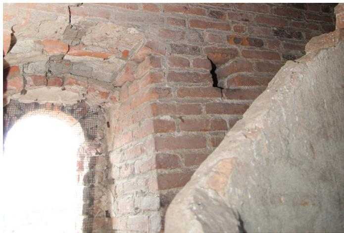
fig. b: apertura verso sud, non in fase con la scala in muratura
