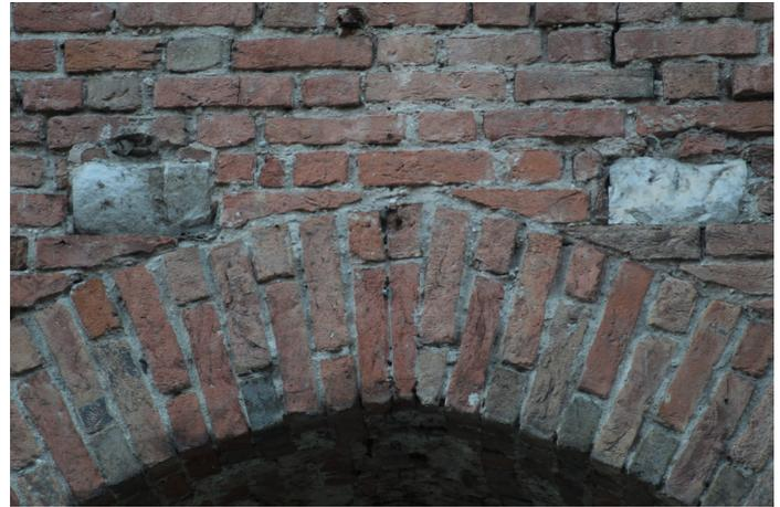
fig. p: traccia di mensole alla base del prospetto sud
