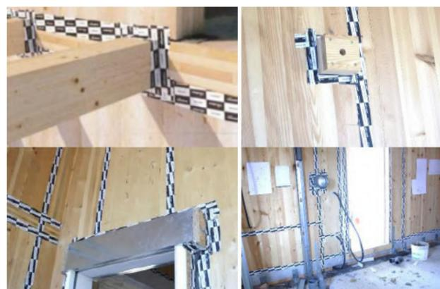
Figura 3, sistema a nastro tenuta all'aria con struttura X-Lam
