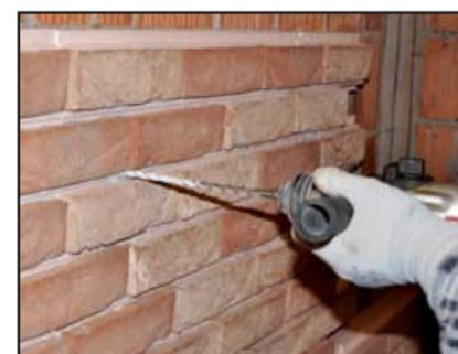
7. FORARE IL MURO, TASSELLARLO ATTRAVERSO RONDELLE DI ANCORAGGIO, CHIUDERE LE VITI CON L'AVVITATORE E INSERIRE I CILINDRI IN EPS.
