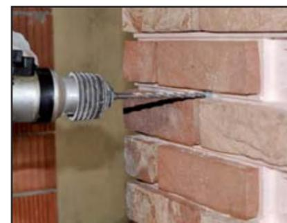
4. FORARE IL MURO, TASSELLARLO ATTRAVERSO RONDELLE DI ANCORAGGIO, CHIUDERE LE VITI CON L'AVVITATORE.
