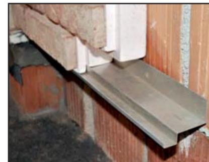
1. FISSARE IN BOLLA IL PROFILO DI PARTENZA LUNGO TUTTA LA BASE DELLA COSTRUZIONE
