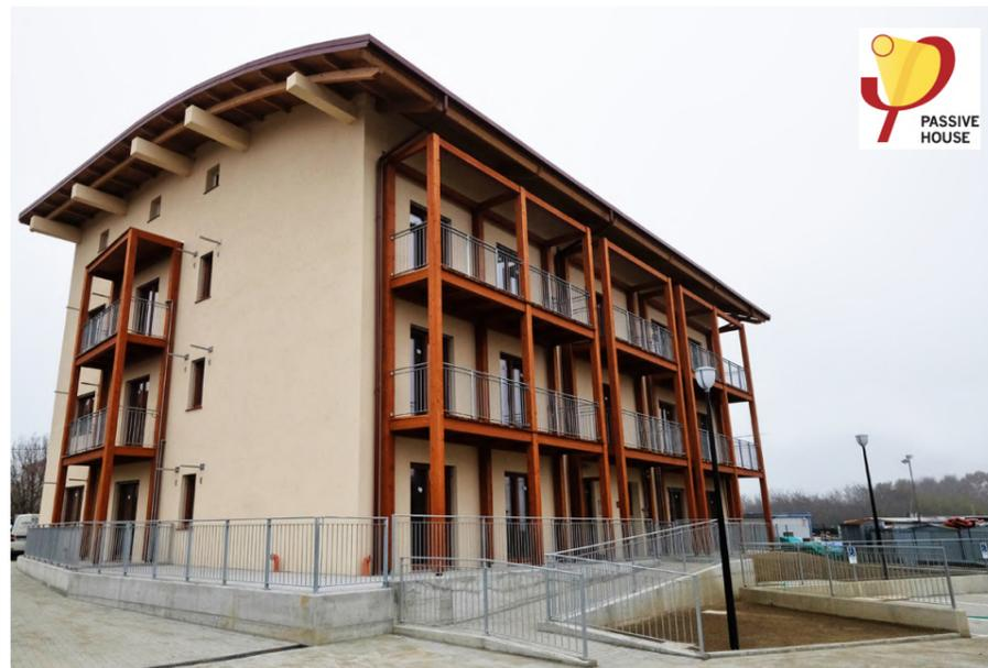
L'edificio esposto a Sud ha una forma compatta (parallelepipedo) per garantire un fattore di forma ideale S/V per le tipologie di appartamenti del progetto. Il lato più lungo è orientato a Sud, dove si trova la maggior parte degli involucri trasparenti per sfruttare l'energia del sole durante l'inverno.
