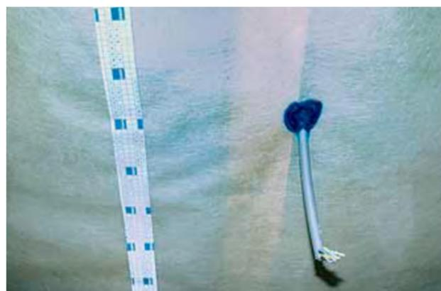
Figura 4, sistema a telo tenuta all'aria
