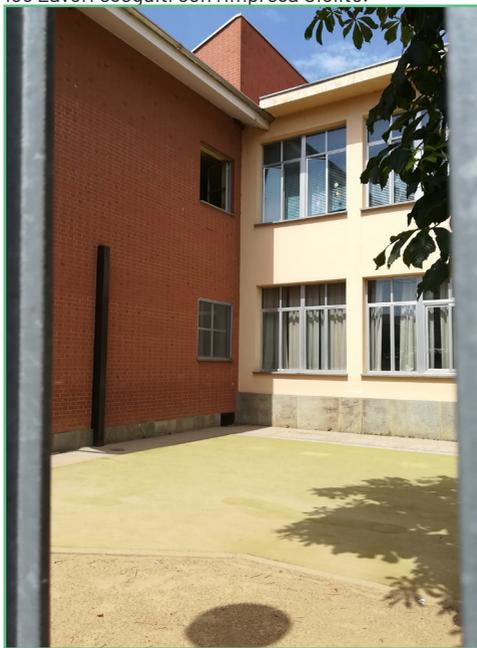
**Immagine:** particolare della giunzione tra le aule ampliate da Dolci nel 1967, intonacate, e l'ala nuova costruita recentemente, in muratura. Dietro è visibile parte delle aule realizzate da Dolci sul lato corto. Fotografia scattata da me il 14.06.2019.
