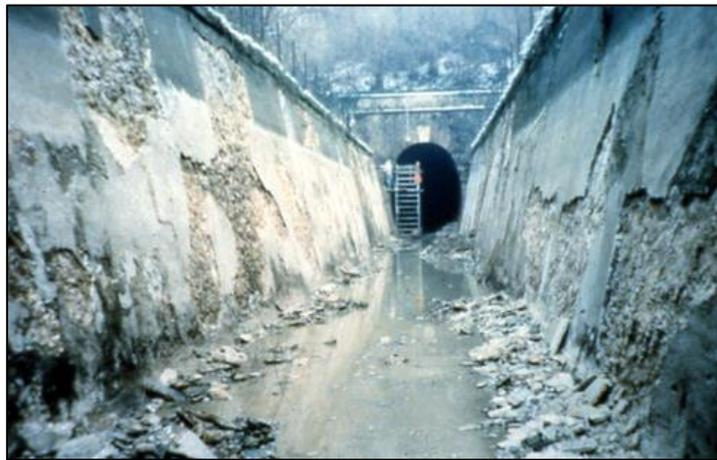
**Figura 3.3** Degrado di un canale per attacco solfatico
