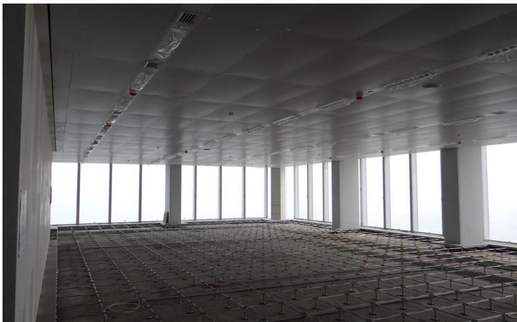
Figura 10: Foto pavimento flottante
