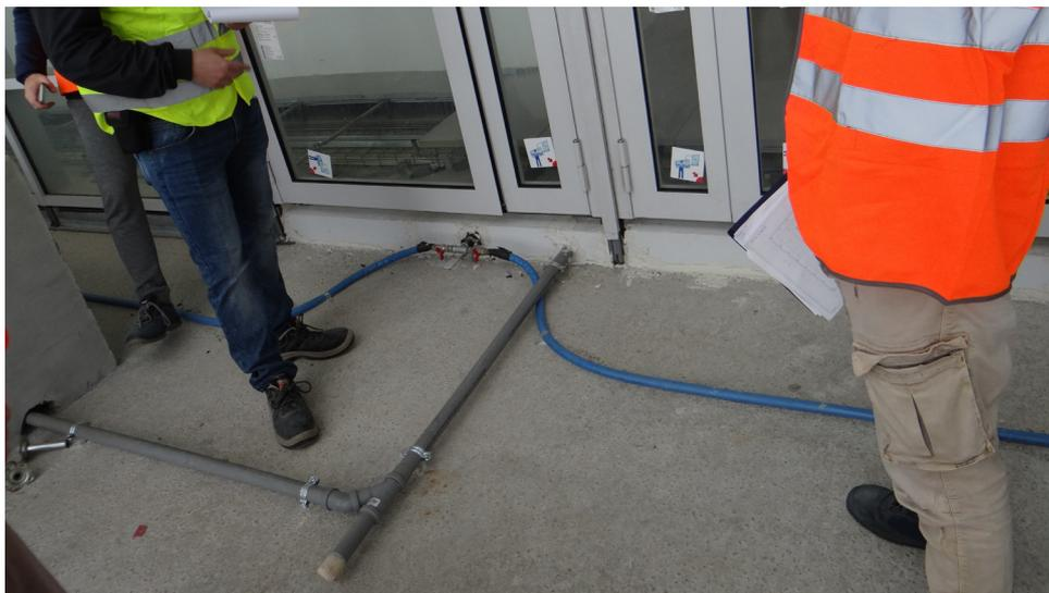
Figura 80: Focus allaccio impianto d'irrigazione giardini d'inverso da rilievo fotografico
