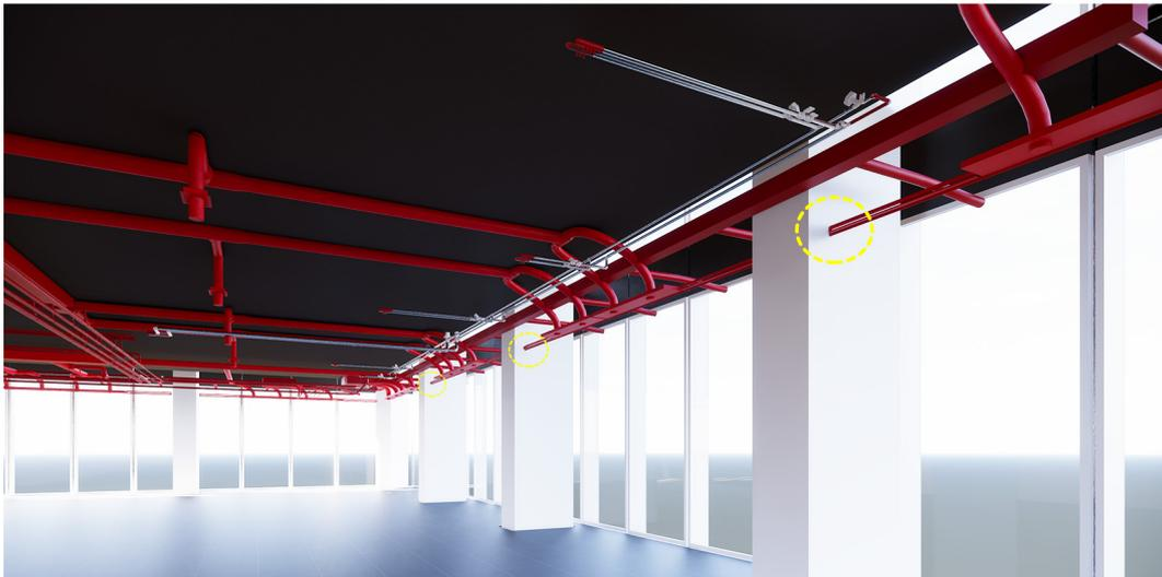
Figura 96: interferenza MEP - strutturale
