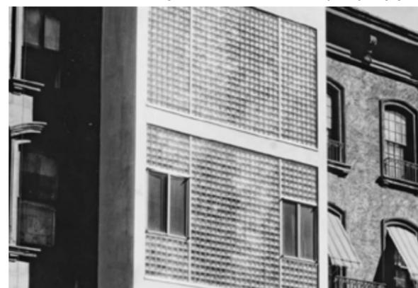
[7] Resistenza ai terremoti: i giunti tra i blocchi vetrati, contenenti silicone elastico, sono in grado di trasferire il movimento all'elemento adiacente ed ognuno ha una tolleranza di 4 mm, permettendo così un'oscillazione generale dell'edificio che così non giunge al punto di rottura.
