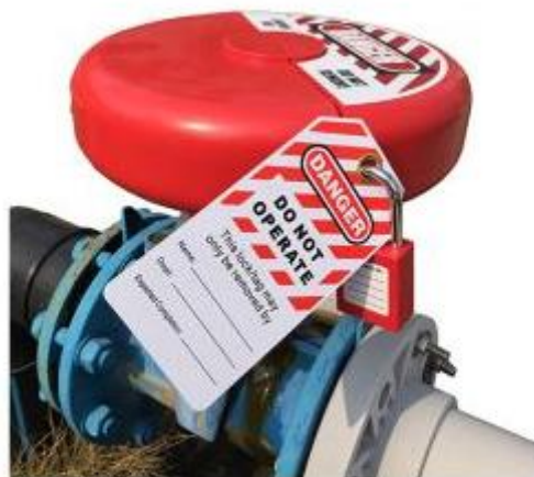
Figura 2.5. - Isolamento idraulico, sezionamento valvola a saracinesca [Lockey]
