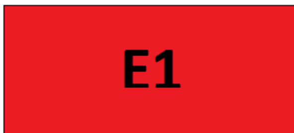
Figura 2.12. - Targhetta che indica la presenza di un quadro elettrico principale
