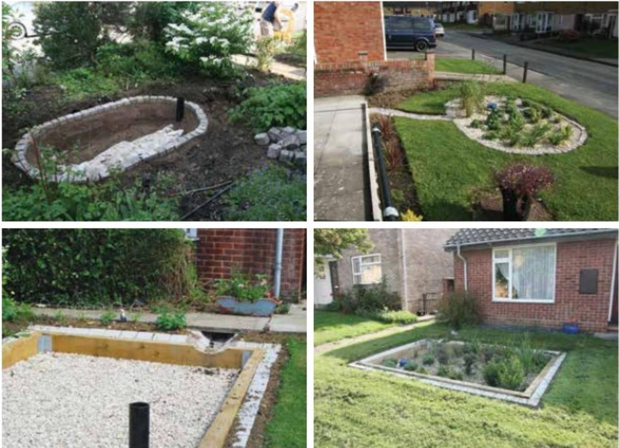
Figura 1.9: Esempi di giardini pluviali in Cheltenham (Woods Ballard, et al., 2015)
