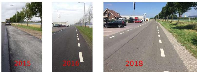
Figura 35 Tronco stradale in Zelanda costituito da bitume modificato con lignina soda (Paesi Bassi) (Gosselink, 2019)
