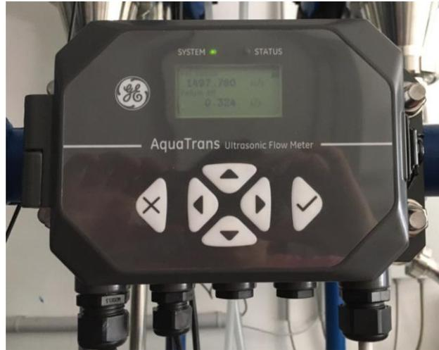
**Figura 5.30 – Fotografia della strumentazione per il settaggio delle variabili e per la visualizzazione istantanea della portata.**
