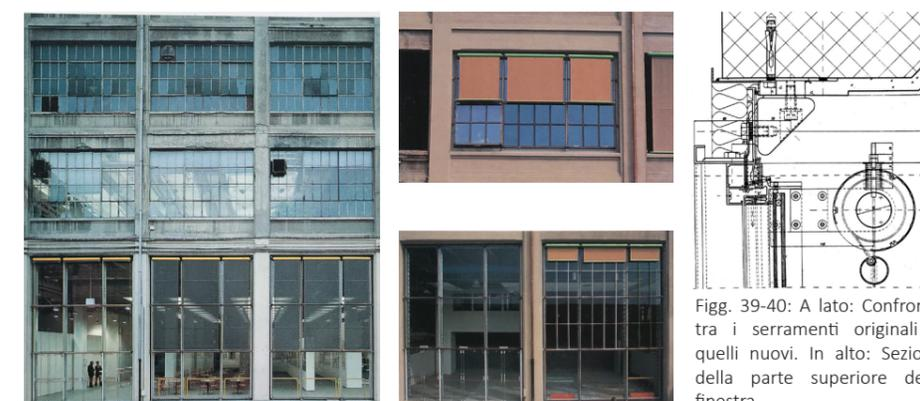
Figg. 39-40: A lato: Confronto tra i serramenti originali e quelli nuovi. In alto: Sezione della parte superiore della finestra.
