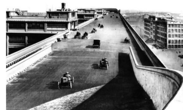
1923. Collaudo delle automobili sulla pista di prova sopraelevata dello stabilimento.
