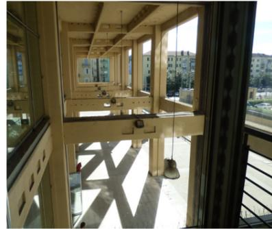
Fig. 48: Maglia strutturale in calcestruzzo armato.
