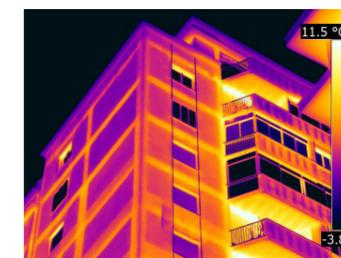
Fig 62: Esempio di individuazione di ponti termici sulla facciata di un edificio.
