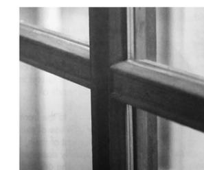
Fig. 4: Dettaglio del serramento restaurato in legno *teak* al piano terra.
