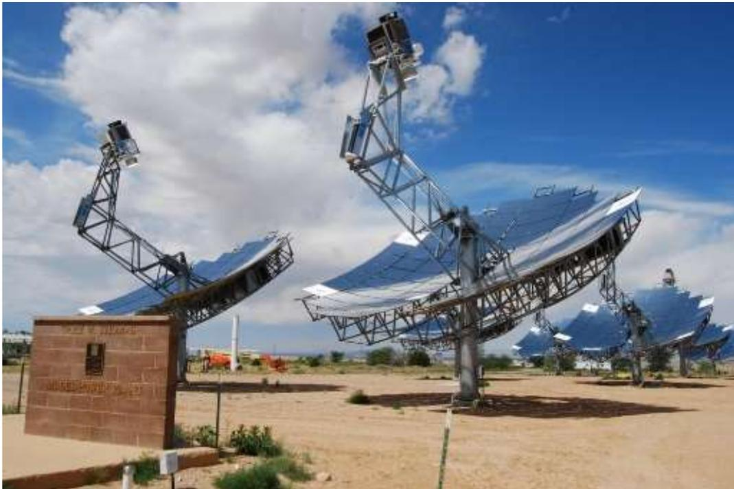
Figura 3.1. Disco solare con motore Stirling, Sandia National Laboratories, Albuquerque, New Mexico. [15]
