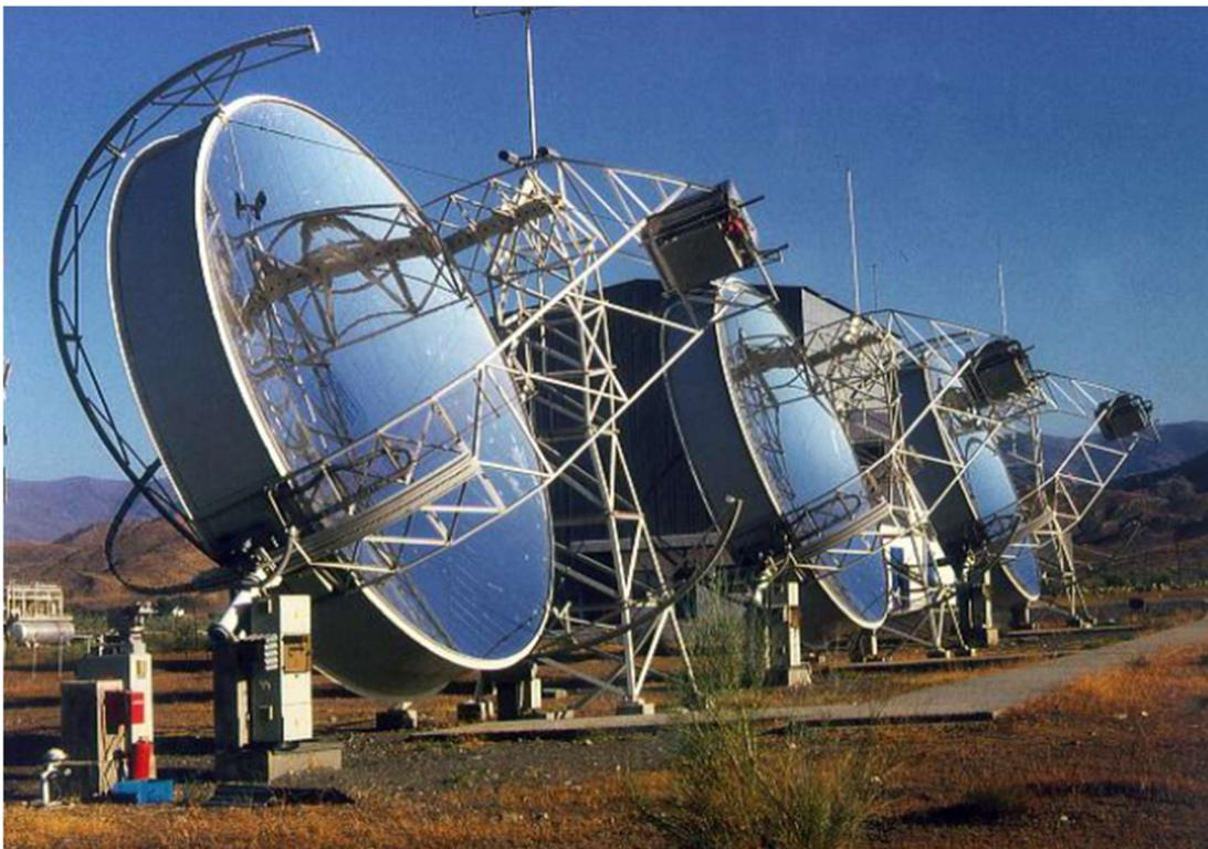
Figura 3.6. Configurazione collettore solare con membrana unica. [16]
