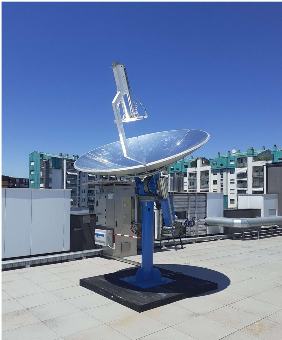
*Figura 3.8. Il concentratore solare a disco installato sul tetto dell'Energy Center*
