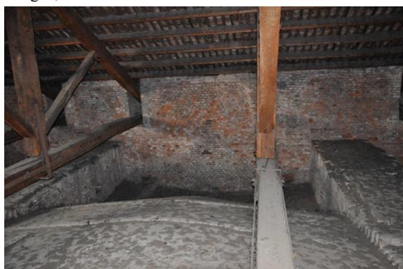
Figura 53 - estradosso volte in copertura
