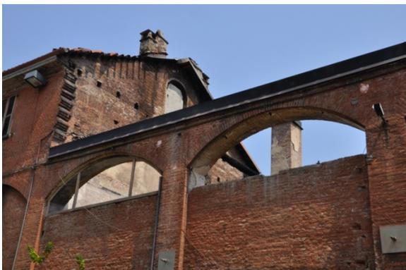
Figura 128- mura perimetrali con l'attuale l'assenza del tetto
