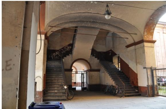
Figura 94 - scalone a forbice al livello terra
