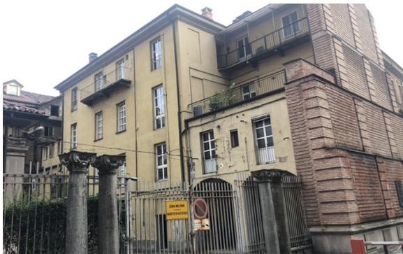
Figura 9 – vista dell'interno corte con il colonnato della corte dell'Accademia originale e ricollocato, che ne sorregge il nuovo confine.
