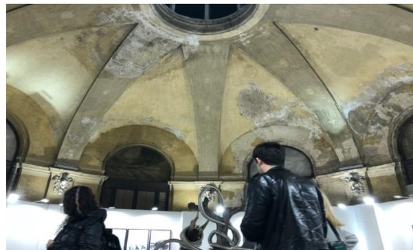
Figura 32 - volta di copertura della rotonda con costoloni
