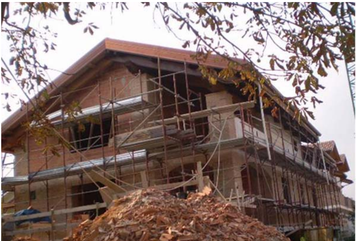
Fase costruttiva del caso studio
