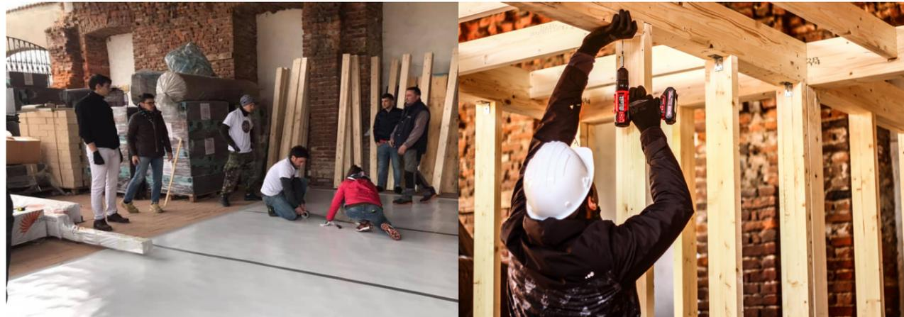
Fig. 37 Posizionamento della guaina impermeabilizzante, fonte: foto scattata dal Team Recyclo
