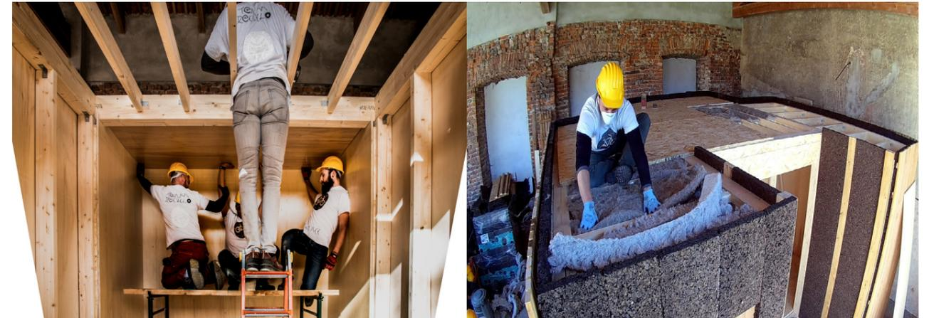
Fig. 43 Taglio e installazione di pannelli di rivestimento interno, fonte: foto scattata dal Team Recyclo
