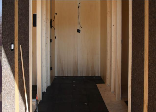
Fig. 48 Taglio e montaggio delle piastrelle di pavimentazione, fonte: foto scattata dal Team Recyclo
