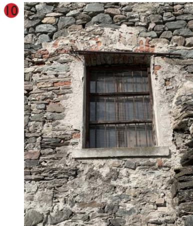
Anche la muratura in prossimità delle aperture della facciata Est presenta delle fessurazioni, a testimonianza del fatto che la struttura è soggetta a carichi che gravano su tessiture murarie danneggiate a causa della disgregazione delle malte.
