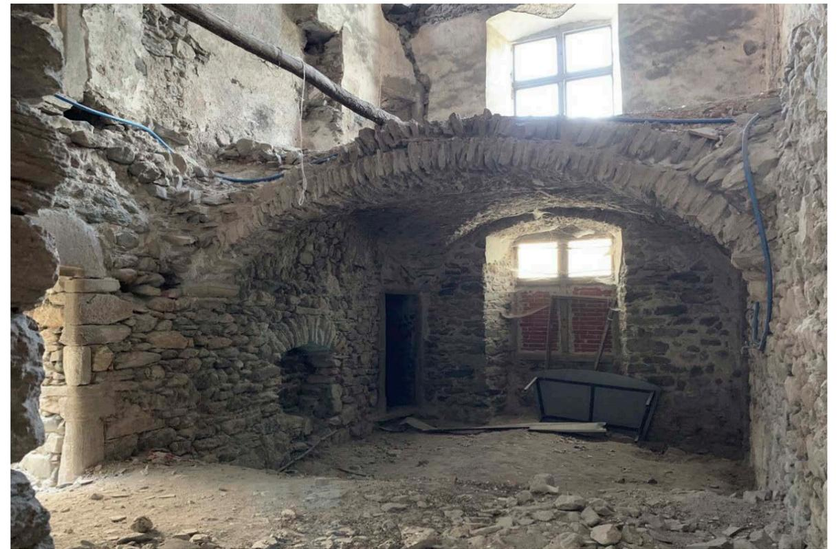
Fig.4 Ambiente interno al nucleo Est, ambiente voltato interessato da gravi crolli.
