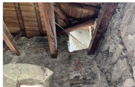
6. Foto del sistema di travi e capriate lignee della copertura.
