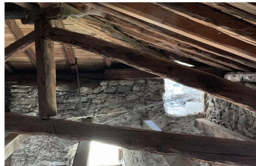
7. Foto delle travi e delle capriate lignee della copertura.
