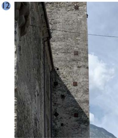
Dall'immagine si nota l'intervento di consolidamento strutturale della torre realizzato attraverso l'impiego di tiranti metallici, con lo scopo di ripristinare il comportamento scolare della struttura, perduto in seguito alla caduta della facciata Sud e dei solai interni alla torre stessa.
