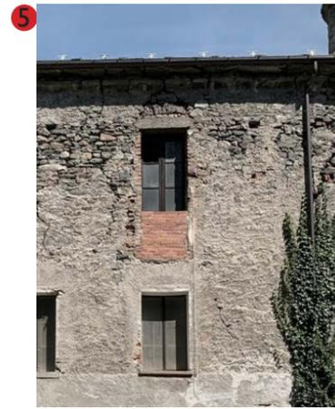
5 Nella foto si notano delle crepe diffuse, soprattutto in prossimità della finestra più in alto, come si può constatare dalla profondità delle crepe in cima alla stessa, probabilmente legate al cedimento dell'architrave. Inoltre, si nota la stessa apertura sia stata oggetto di un intervento di parziale tamponamento con l'impiego di laterizi.
