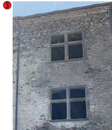
3 Anche in questo caso, si notano delle crepe ai lati delle finestre crociate del corpo Est, elementi di particolare pregio architettonico e in buono stato di conservazione. Le fessurazioni sono dovute all'esposizione ai cicli di gelo-disgelo che hanno deteriorato la malta tra gli elementi lapidei, generando stati di tensione.
