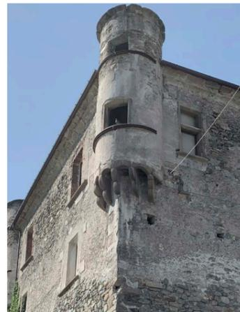
4 In quest'altra immagine si nota l'intervento di consolidamento strutturale delle torrette angolari. Esso è stato realizzato con delle cerchiature metalliche che contrastano la rotazione di queste verso l'esterno a causa dell'ammorsamento ormai danneggiato con le murature perimetrali del corpo Est.
