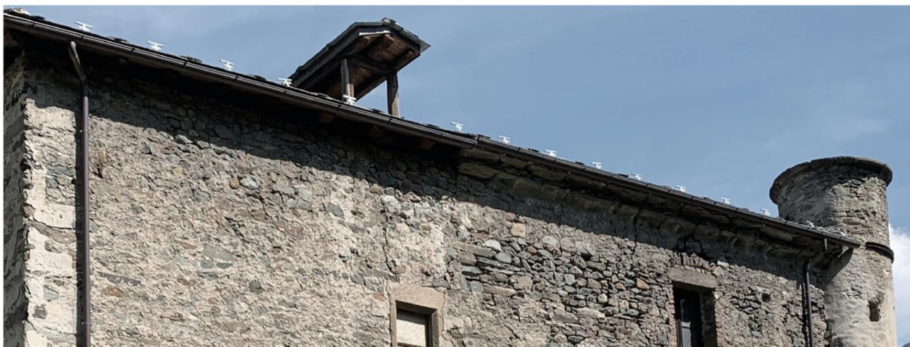
7. Foto di dettaglio della porzione Sud del cornicione che circonda su tre lati il corpo più antico, quello Est. Si nota, a partire dalla metà della facciata Sud, l'interruzione improvvisa di tale elemento di finitura, a testimoniare la successiva aggiunta del corpo scalare.
