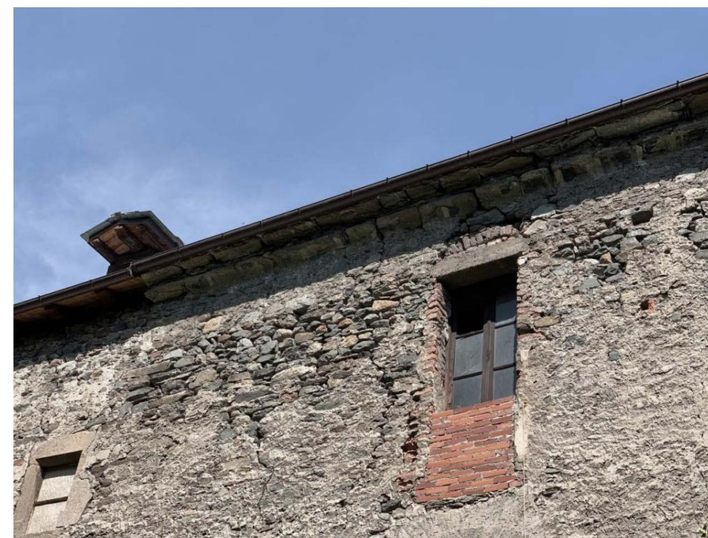
Fig. 11 Cornicione in pietra appartenente al primo blocco costruttivo a Est. Dove si interrompe inizia la porzione successiva del fabbricato, che ha inglobato al suo interno il cornicione del lato Ovest della prima struttura.
