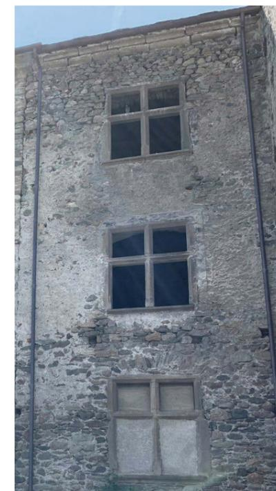
Fig. 10 Aperture a crociera del corpo centrale.
