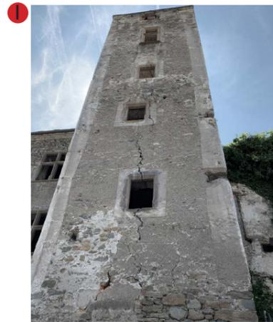
1 Il lato Nord della torre presenta delle crepe che la percorrono in tutta la sua altezza. Esse sono state generate principalmente a causa del crollo del lato Sud della torre stessa e dei sei solai che, originariamente erano al suo interno, contribuendo al comportamento scafole della struttura.
