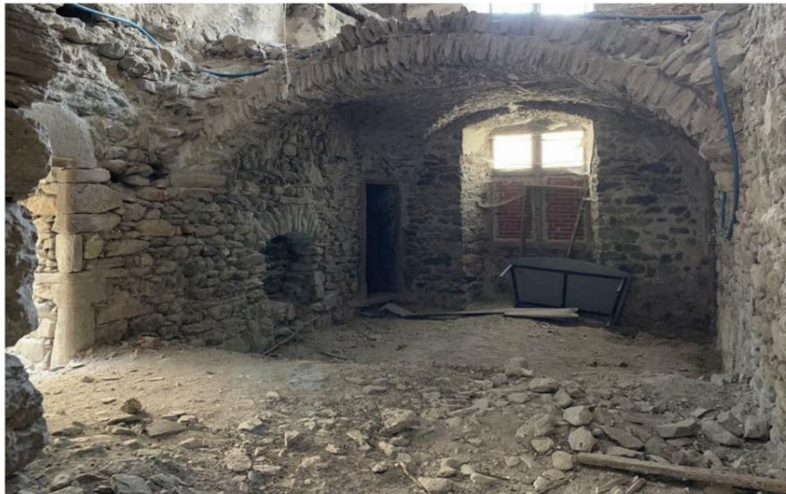
6. Foto dell'ambiente del corpo centrale: si notano il crollo di una delle volte e l'accesso della torre.
