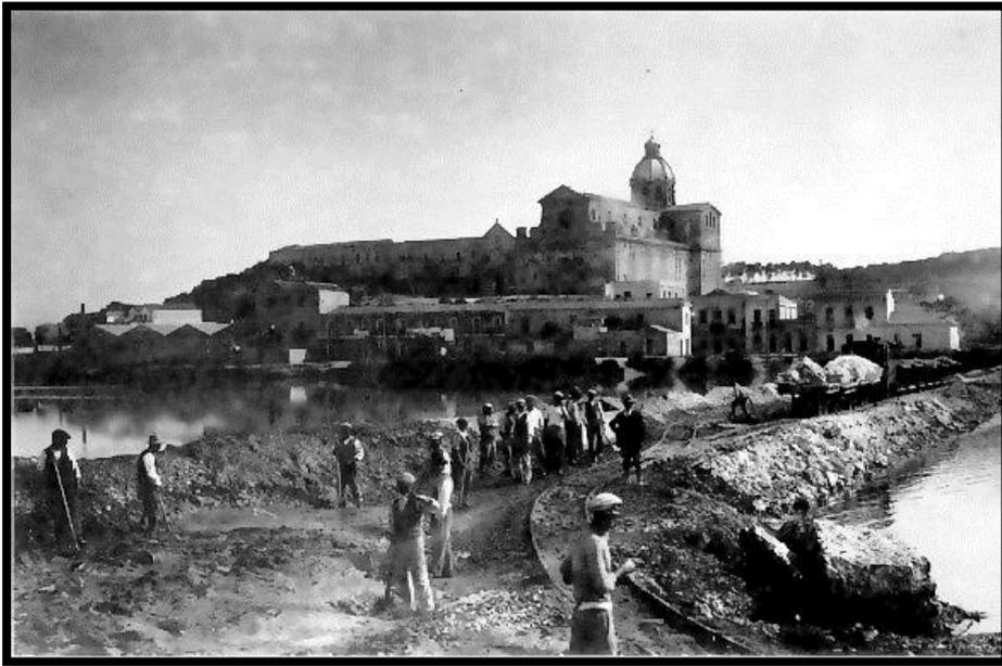
**Figura 1.3 - Foto storica dei lavori di bonifica nella zona di “Su Siccu”. Sullo sfondo, la basilica di Bonaria. Sulla destra, la ferrovia decauville tramite cui i massi provenienti dalla vicina cava erano trasportati al porto<sup>33</sup>**
