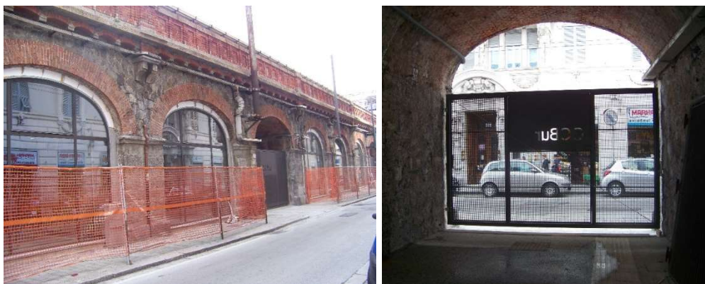
Immagini 50,51 – Cinque voltini ferroviari (proprietà di RFI) interessati dai lavori di riqualificazione e ingresso al centro civico Buranello, ingresso lato via Buranello, foto scattate durante sopralluogo in data 21.02.2020
