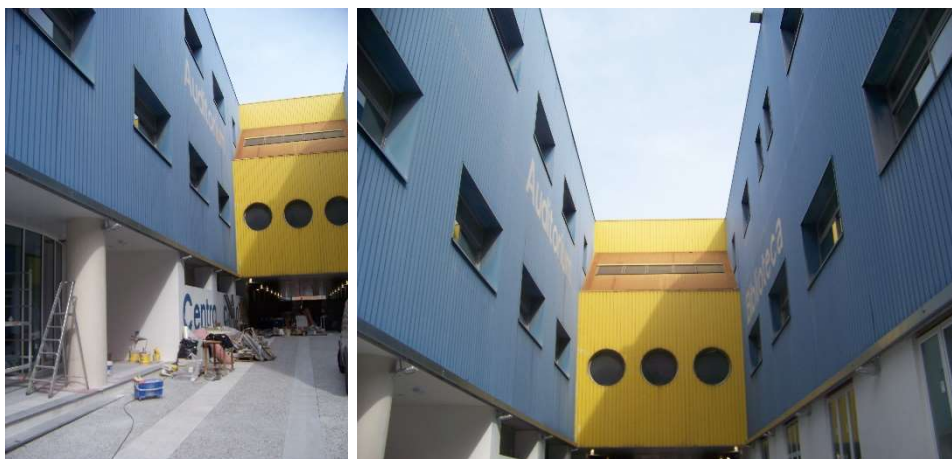
Immagini 42,43 – Ingresso al centro civico Buranello, foto scattate durante sopralluogo in data 21/02/2020
