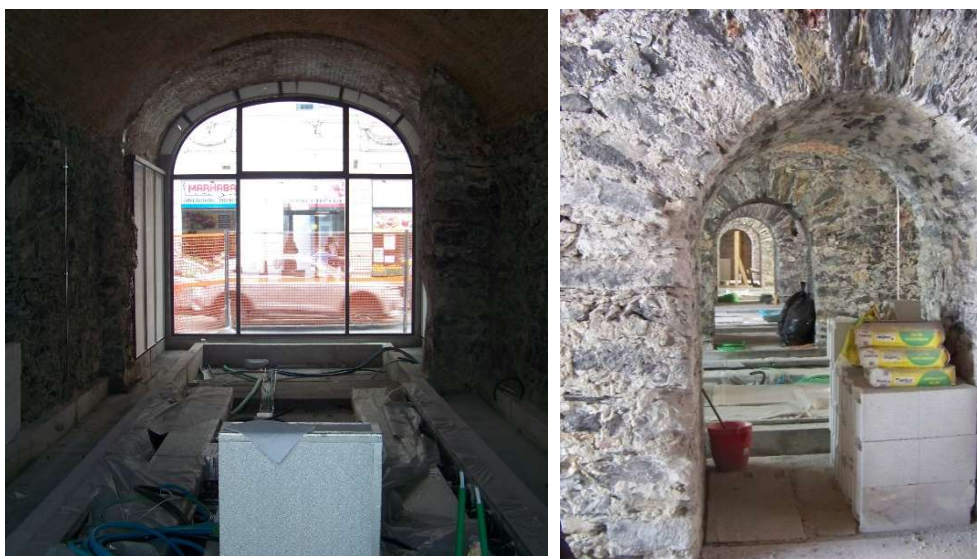
Immagini 52, 53 – Voltini ferroviari in ristrutturazione, foto scattate durante sopralluogo in data 21.02.2020
