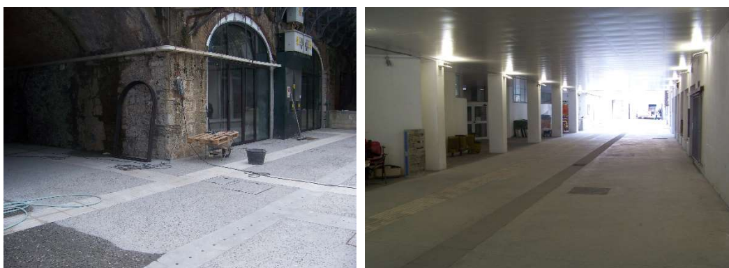
Immagini 44,45 – Interventi sulla pavimentazione esterna al centro civico Buranello, foto scattate durante sopralluogo in data 21/02/2020
