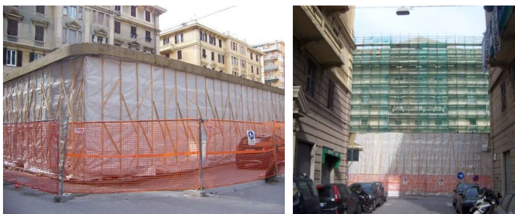
Immagini 57,58 – Interventi di ristrutturazione mercato in Piazza Tre Ponti, foto scattate durante sopralluogo in data 21.02.2020
