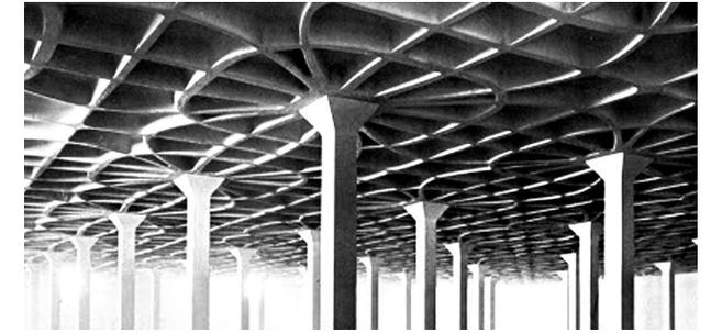
Fig. 75 - Lanificio Gatti - prog. n.3318-26, solaio a nervature isostatiche (1951).
