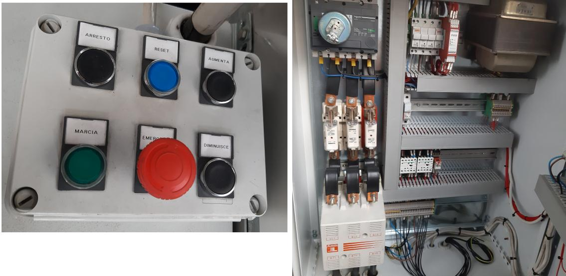
Figura 5.1: A sinistra la pulsantiera esterna del quadro di comando dell'autotrasformatore, a destra una foto del circuito interno.
