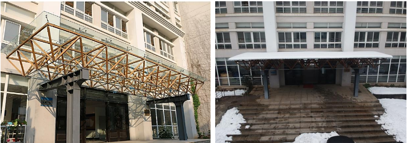
Figura 82 Struttura reticolare in glulam e acciaio realizzata come copertura dell'ingresso della facoltà di ingegneria civile presso la Nanjing Tech University (China) (37).
