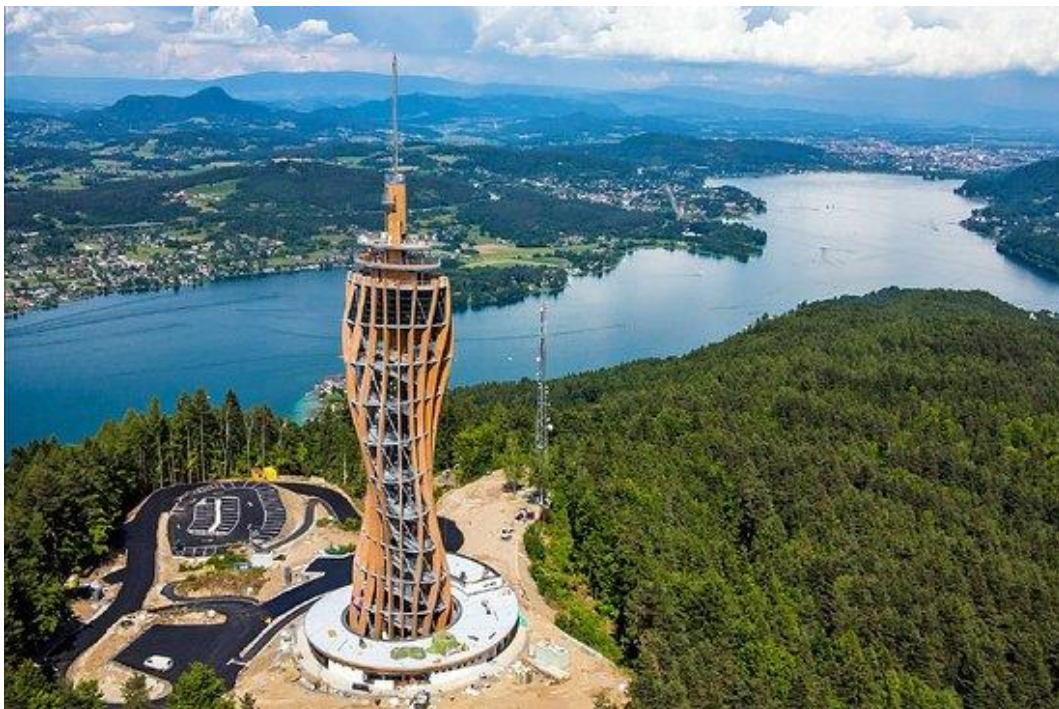
Figura 35 Torre panoramica in legno lamellare sul Pyramidenkogel, Keutschach –AT. Fonte: https://www.rubner.com/
