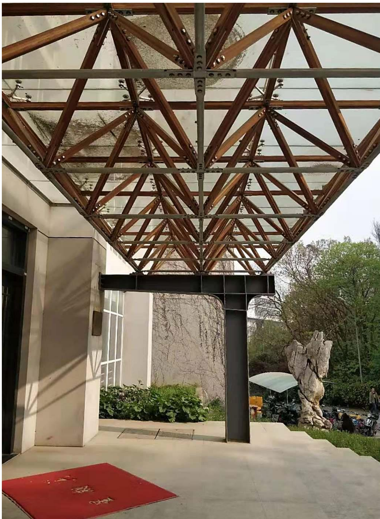
Struttura reticolare in glulam e acciaio realizzata come copertura dell'ingresso della facoltà di ingegneria civile presso la Nanjing Tech University
