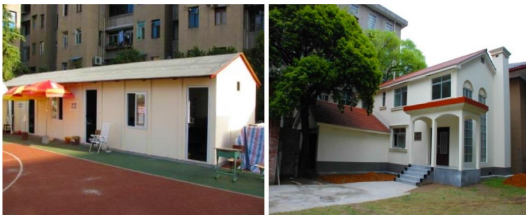
Figura 41 Applicazione ingegneristica delle capriate di bambù: a sinistra una casa mobile in bambù nel Sichuan dopo il terremoto di Wenchuan del 12 maggio 2008, a destra una villa in bambù all'università di Hunan (36).
