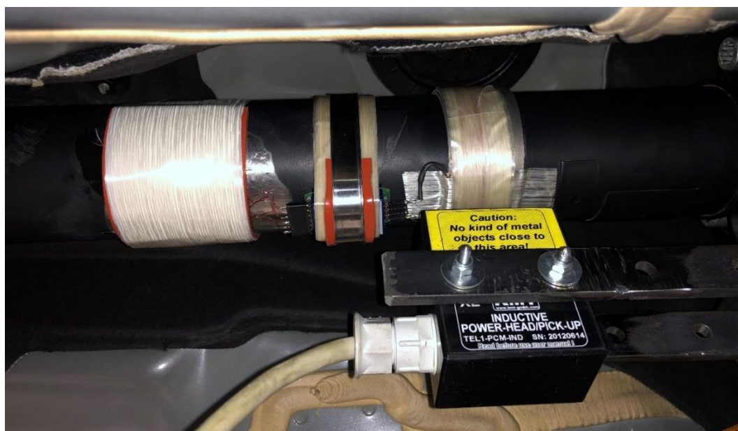
Figura 3-10: Posizionamento antenna di trasmissione.
