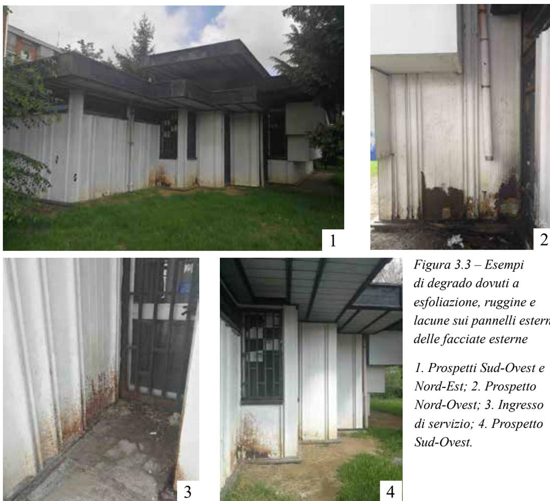
*Figura 3.3 – Esempi di degrado dovuti a esfoliazione, ruggine e lacune sui pannelli esterni delle facciate esterne*
