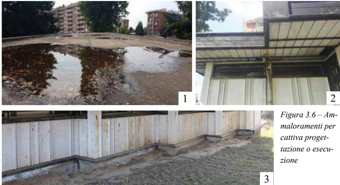
*Figura 3.6 – Ammaloramenti per cattiva progettazione o esecuzione*
