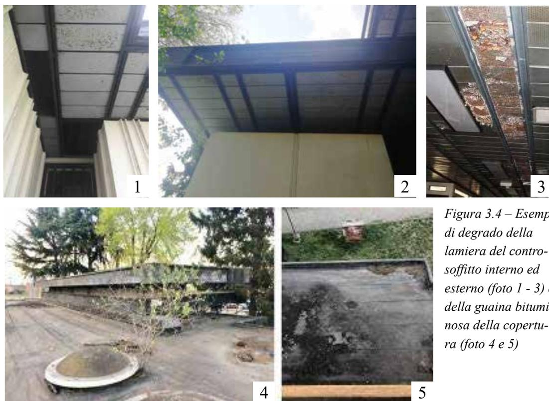
*Figura 3.4 – Esempi di degrado della lamiera del controsoffitto interno ed esterno (foto 1 - 3) e della guaina bituminosa della copertura (foto 4 e 5)*
