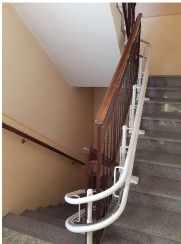
FIGURE 63: MONTASCALE MONTATO SULLA RINGHIERA
