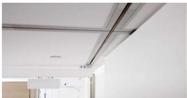
FIGURE 75: BINARI INCASSATI A SOFFITTO PER LA MOVIMENTAZIONE DEL SOLLEVATORE A BINARI
