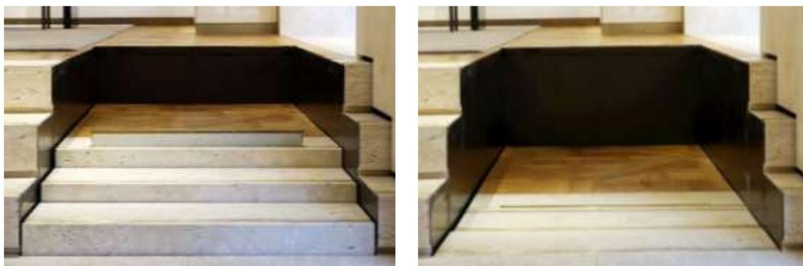
FIGURE 61: ESEMPIO DI PIATTAFORMA DI SOLLEVAMENTO INTEGRATA AI GRADINI
