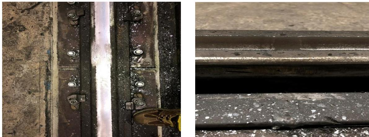
Figura 52) Queste due immagini mostrano la “pista” ,completamente lucida, lasciata dal traslo sulla testa (si notano le scaglie d'acciaio a lato provenienti dalla testa).
