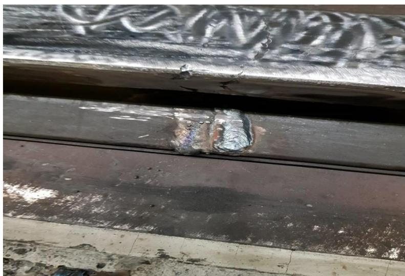
Figura 61) Foto rappresentante la giunta recuperata grazie ad una saldatura a filo. Si nota il segno della molatura sulla corona della rotaia per renderla più liscia.
