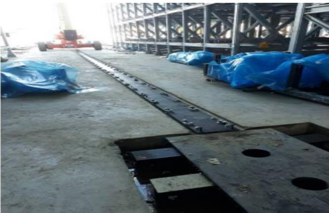
Figura 23) Fase iniziale in cui si crea la trincea per creare la base d'appoggio e la disposizione della piattabanda/soletta.
