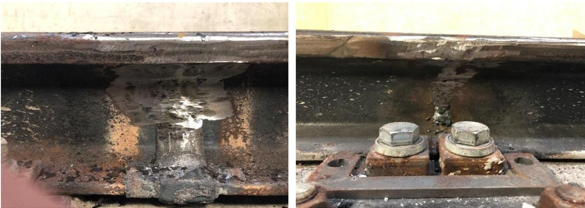
Figura 60) Confronto tra una giunta realizzata con l'alluminotermia e un'altra usando la saldatura a filo continuo. Si riesce a riconoscerle in base alla morfologia della linea di giunzione. In quella di sinistra, si nota uno strato uniforme del cordone (caratteristico dell'alluminotermia), mentre a destra, è inconfondibile la tipica linea di giunzione realizzata con il filo continuo (tra l'altro si vedono piccoli schizzi solidificati in basso).
