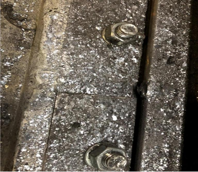
Figura 62) La presenza di queste scaglie denota l'eccessiva usura da parte del contatto tra ruote e rotaia.
