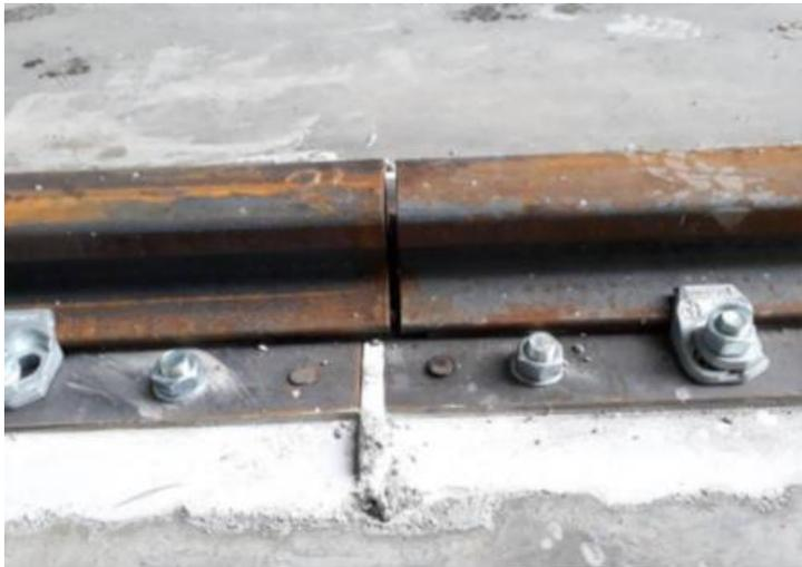
Figura 29) Fase di allineamento delle due rotaie.
