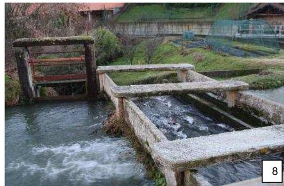
Tramite apposito ponte canale, scavalca il Canale di Magliano lasciando cadere nello stesso parte delle acque, per poi continuare il suo percorso, sfociando nel torrente Brobbio
