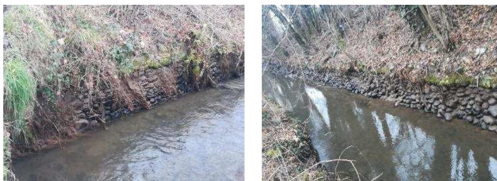
Vista del muro di rivestimento del canale realizzato con pietrame
