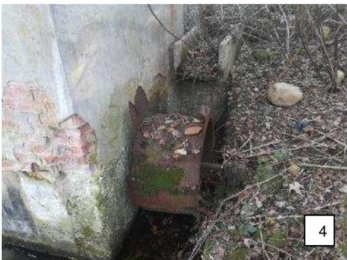
Resti di ruota idraulica
