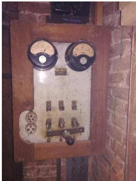
Quadro elettrico per impulso al motore centrale, con attacco a baionetta
