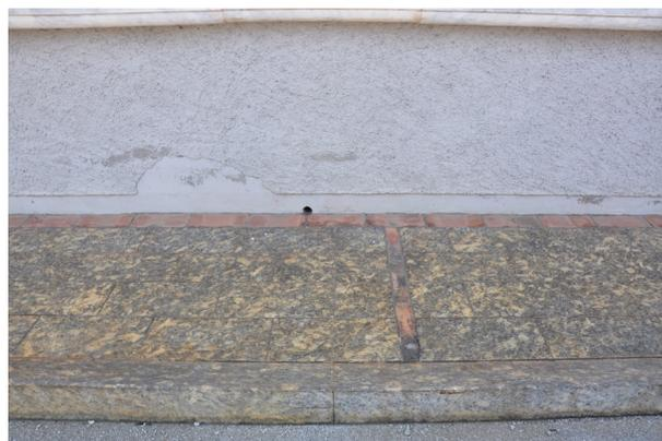
Edificio 1: Concrezione, Distacco, Efflorescenza, Fessurazione, Macchia, Patina, Usura
