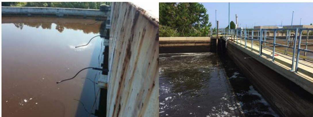
Figura 6.26: Esempio di applicazione della tecnologia Lagun'Air® relativa ad una vasca di decantazione. Sono visibili sulle due pareti gli ugelli di diffusione.
