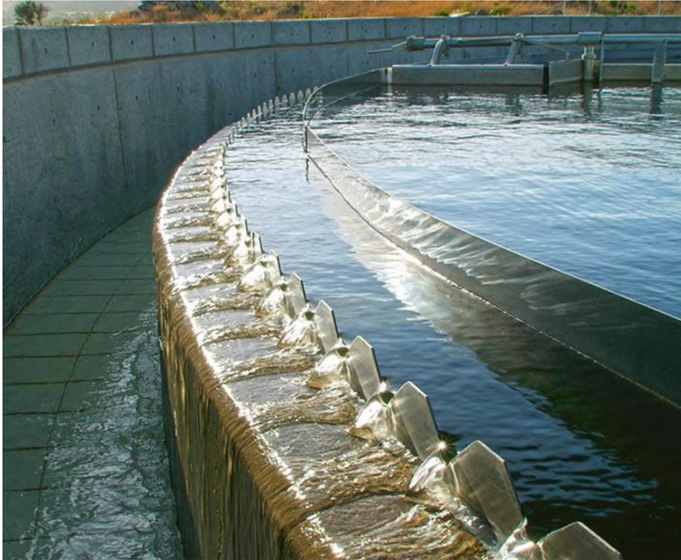
Figura 6.2: Particolare delle dighe effluenti a stramazzo della vasca di sedimentazione (“effluent weirs”). La turbolenza favorisce in questi punti la maggiore volatilizzazione dei composti odorigeni [91].
