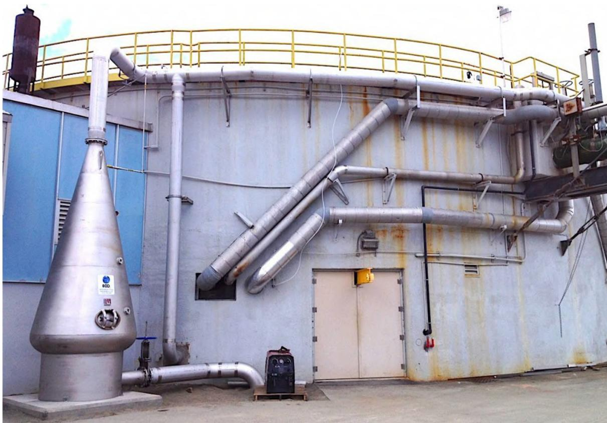
Figura 6.5: Esempio di applicazione della super-ossigenazione *ECO2* per una vasca di sedimentazione primaria dell'impianto di trattamento di Anson-Madison (U.S.A.) [90]
