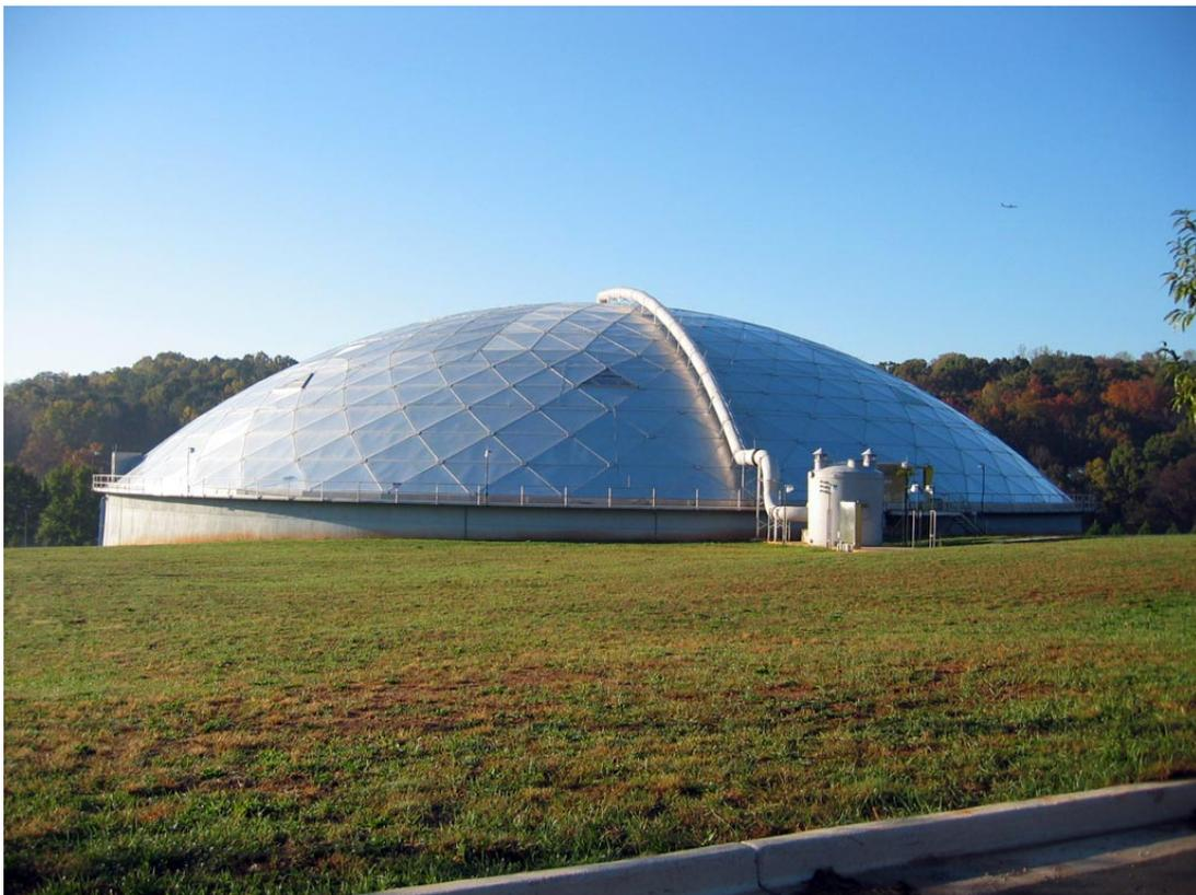
Figura 6.12: Esempio di copertura a cupola per vasca circolare realizzata con pannelli di alluminio [82] - è visibile il sistema di aspirazione e trattamento dell'aria.
