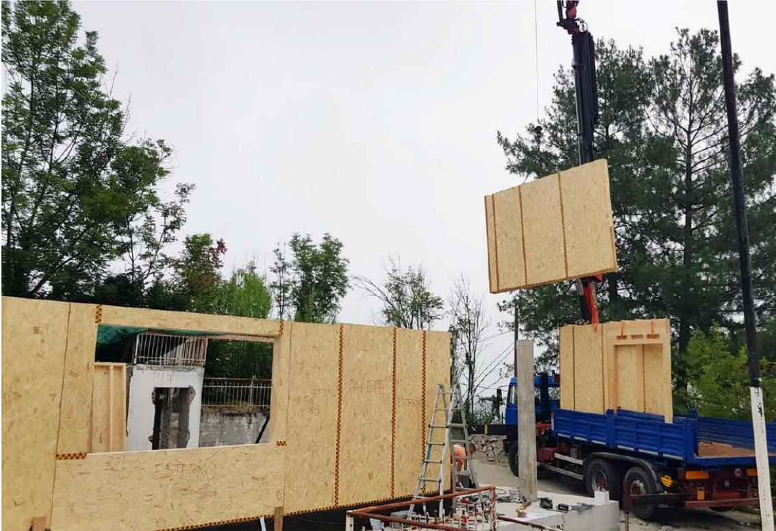
*Figura 1.10 Fase di movimentazione e collocamento di una parete portante tramite camion-gru all'interno di un cantiere VASS Technologies*
