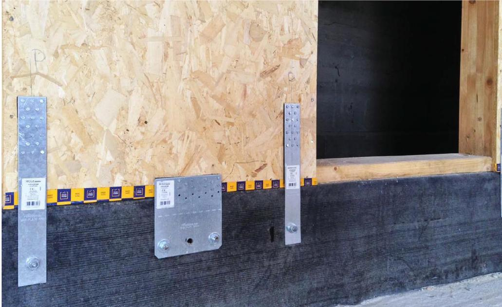
*Figura 1.9 Staffe metalliche per la connessione tra parete e cordolo in C.A.*
