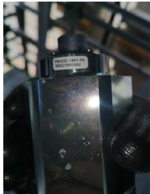
Figura 4.2. Presa capacitiva installata in una fase
