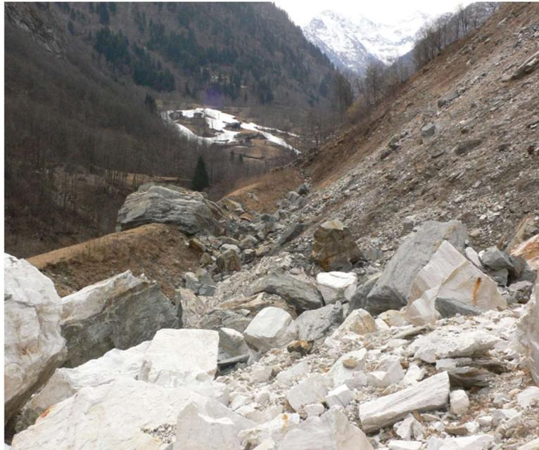
*Figura 3-10* Blocco di 508 m<sup>3</sup> conficcato sulla testa del rilevato.
