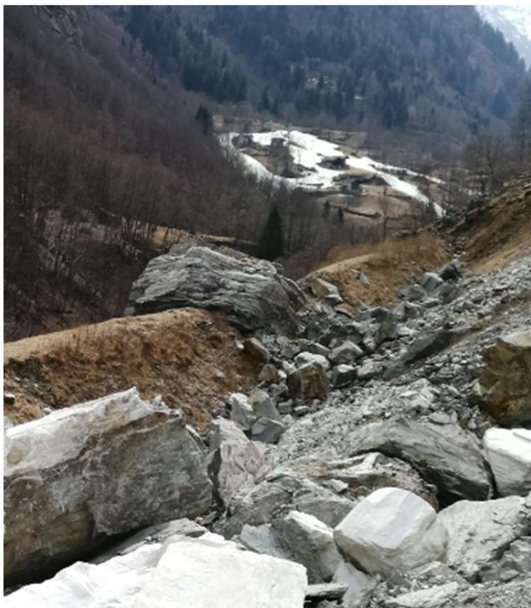
*Figura 5-1 Foto del rilevato paramassi con un blocco di grandi dimensioni conficcato in testa*
