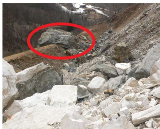
*Figura 5-4 Blocco 2 Improntato sul rilevato*
