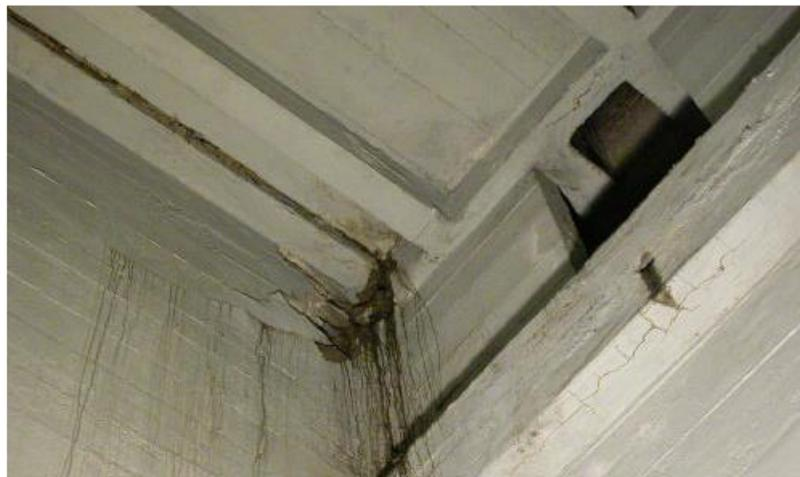
*Figura 3.4-Fessurazioni parallele alle barre di armatura*
