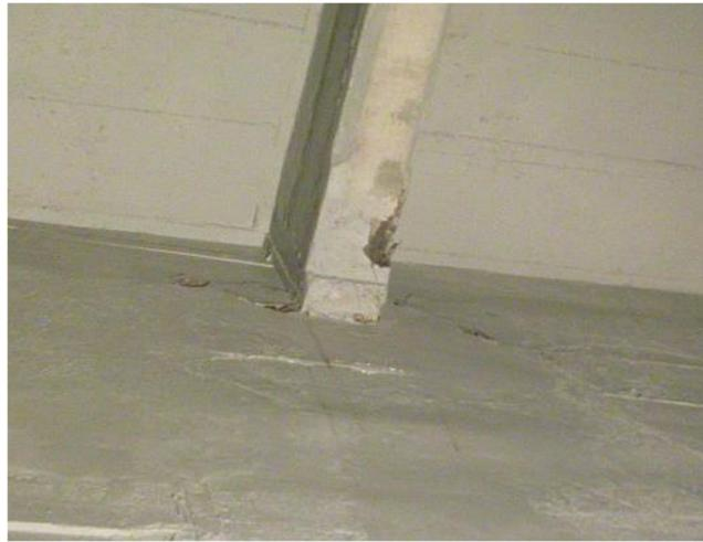
*Figura 3.5- Segni di scorrimento tra trave longitudinale e setto frontale della pila*
