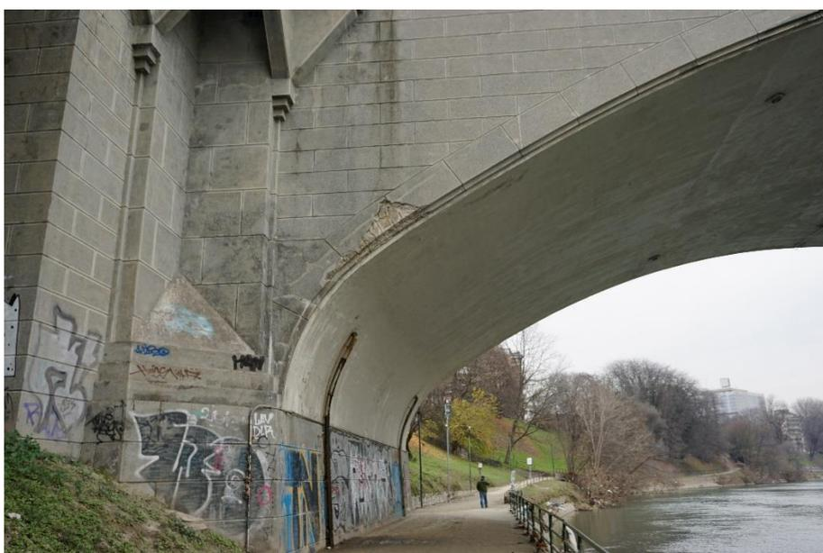
*Figura 3.8- Particolare di arcata privo di rivestimento e con armature a vista*
