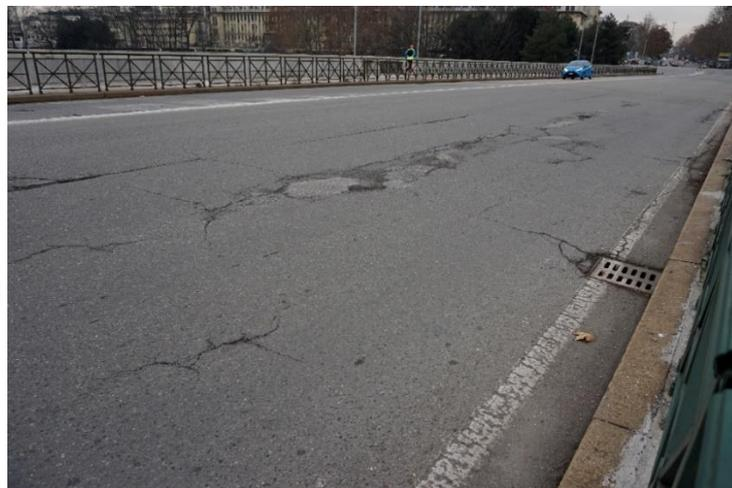
*Figura 3.10- Buche e rattoppi diffusi sulla pavimentazione*
