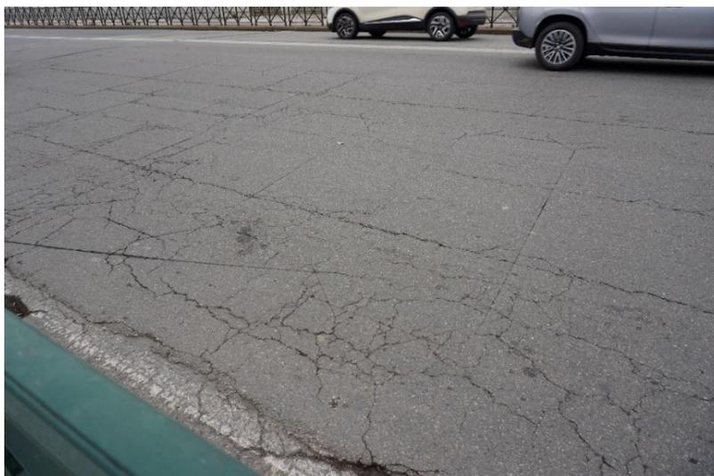
*Figura 3.11- Fessurazioni ramificate sulla pavimentazione*
