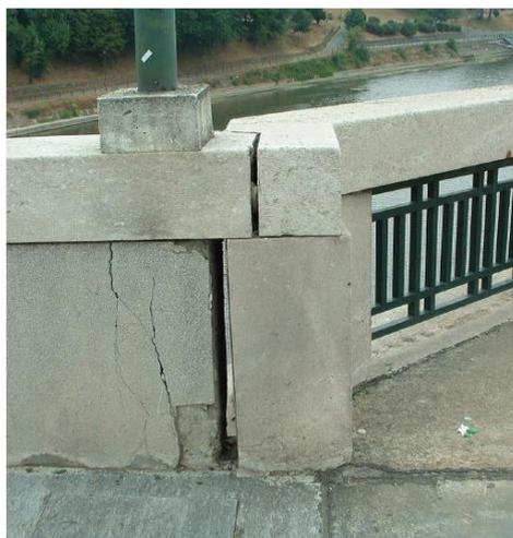
*Figura 3.6- Dissesti del parapetto in corrispondenza delle lesioni del timpano*
