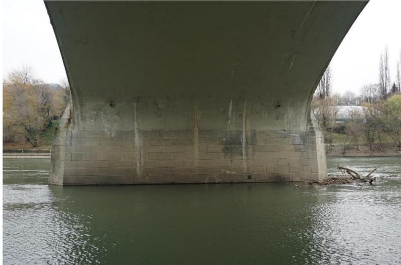
*Figura 3.9- Particolare con macchie di umidità diffusa*
