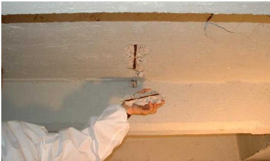
*Figura 3.2- Espulsione del copriferro causata dal rigonfiamento di un'armatura ossidata*
