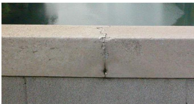
*Figura 3.7- Sbrecciature per compressione del coronamento in pietra*
