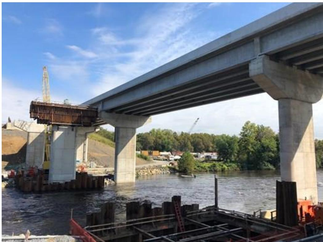
*Figura 5.1 – Impalcato in calcestruzzo armato precompresso*
