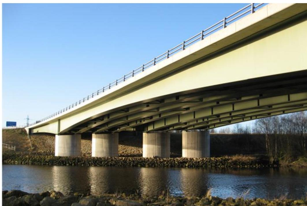
*Figura 5.2 - Impalcato con travi in acciaio e soletta in calcestruzzo collaborante*
