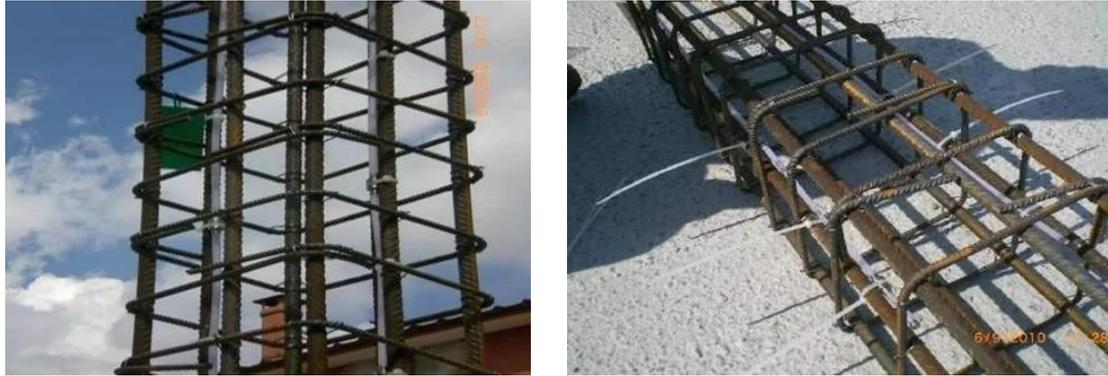
Figura 1.9 – Sensori a fibra ottica fissati alle barre delle armature all'interno degli elementi strutturali
