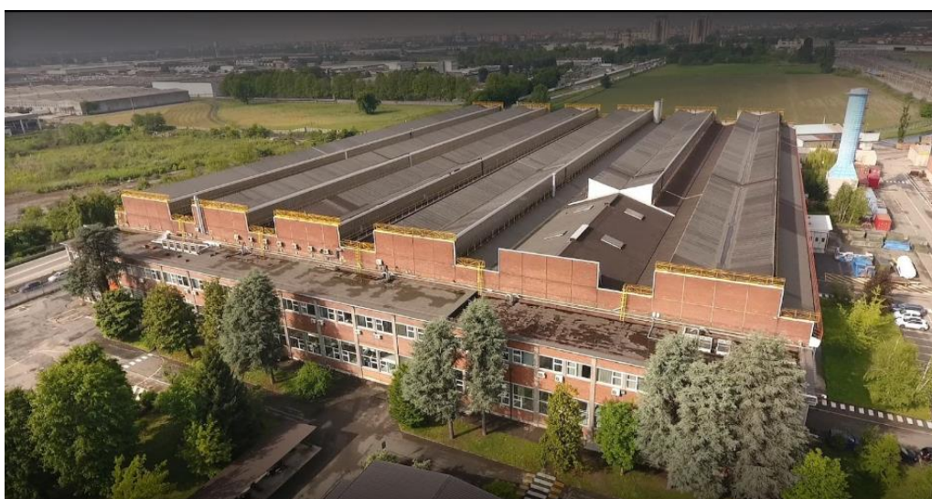
Figura 49: Tetto del Fabbricato A
