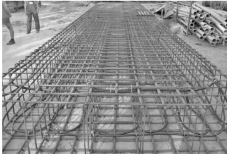
Figura 2.12 Tubazioni di assorbimento collegate alla gabbia di armatura di un diaframma (Brandl, 2006)
