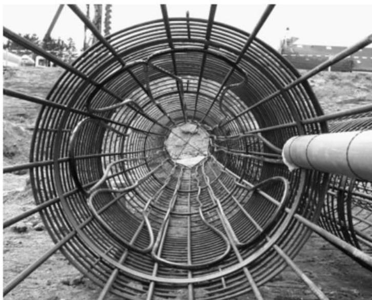
*Figura 2.10 Tubazioni di scambio termico fissate alla gabbia di armatura di un palo di fondazione (Brandl, 2006)*
