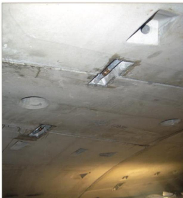
Figura 3.4 Rivestimento della galleria con connessione tra i tubi di scambio termico dei conci (Franzius and Pralle, 2011)
