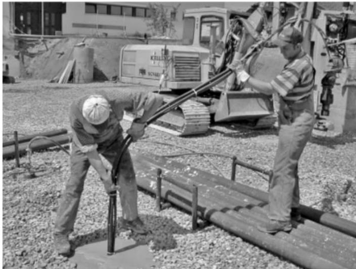
*Figura 2.11 Inserimento delle tubazioni di assorbimento in un palo montato tramite una tubazione di sostegno in acciaio (Brandl, 2006)*
