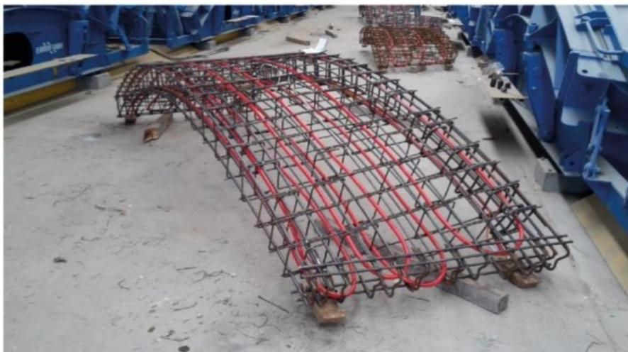
*Figura 3.1 Tubi di scambio termico collegati alla gabbia di armatura di un concio energetico (Barla et al., 2019b)*
