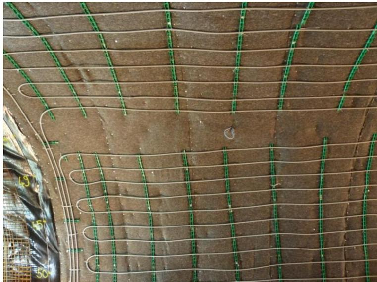
*Figura 2.18 Tubi di assorbimento della galleria di Fasanenhof (Schneider and Moormann, 2010)*
