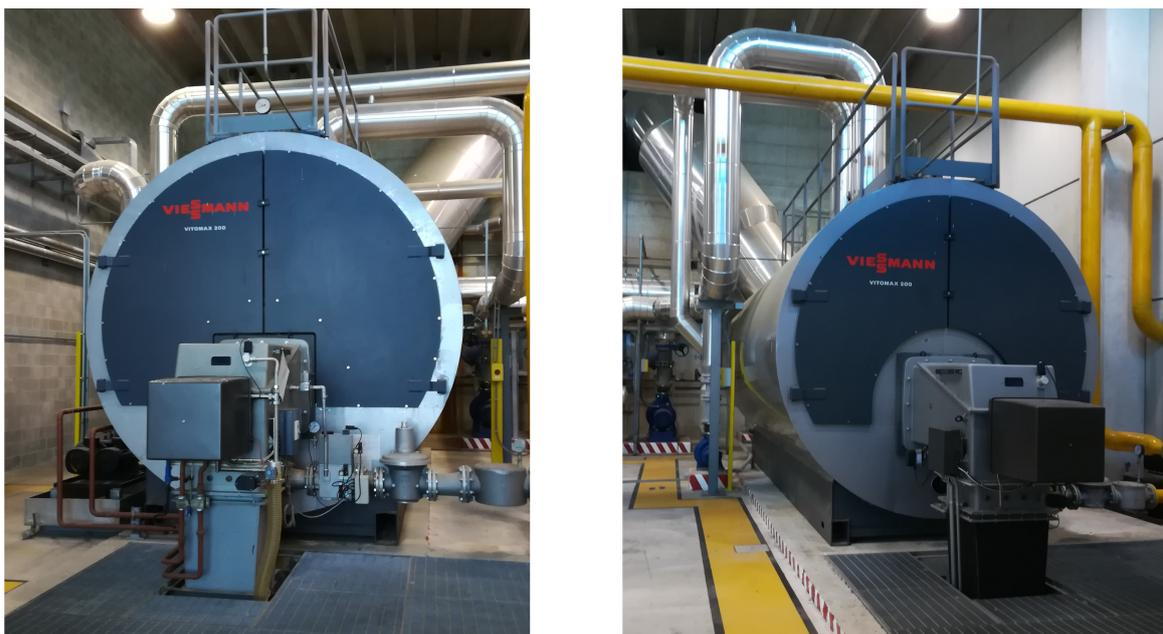
*Figura 4.8: Caldaie Vitomax 200 presenti in centrale.*
